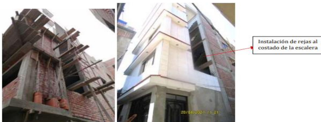
Imagen 7 y 8: Vista lateral desde el exterior del inmueble Instalación de reja al costado de la escalera interna, y se verifica el tarrajeo en los ambientes interiores. Fuente: Inspección del 07/12/2020 y 20/04/2021
