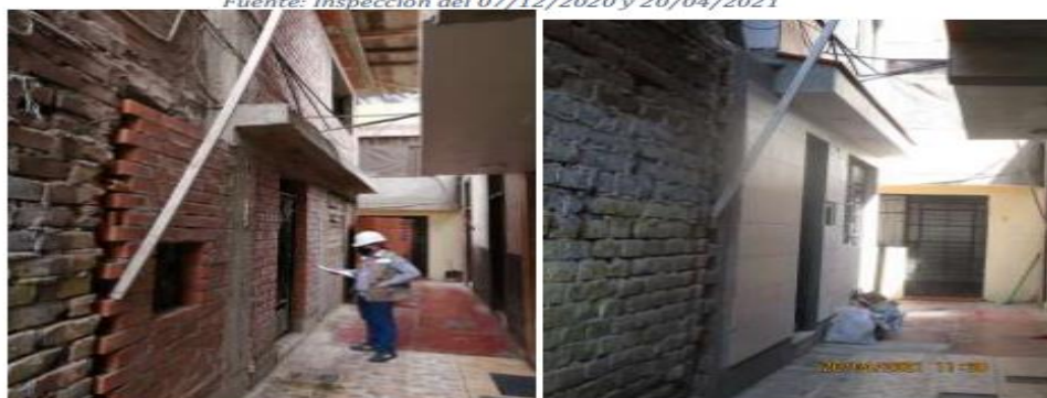
Imagen 5 y 6: Vista desde el exterior del inmueble
