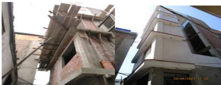
Imagen 3 y 4: Vista desde el exterior del inmueble
