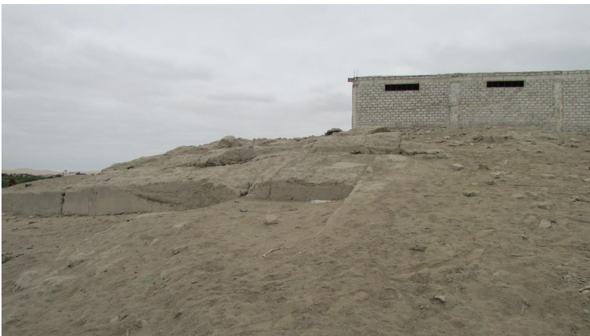
Figura 07. Estructura de material noble encima de los muros de tapiales.
