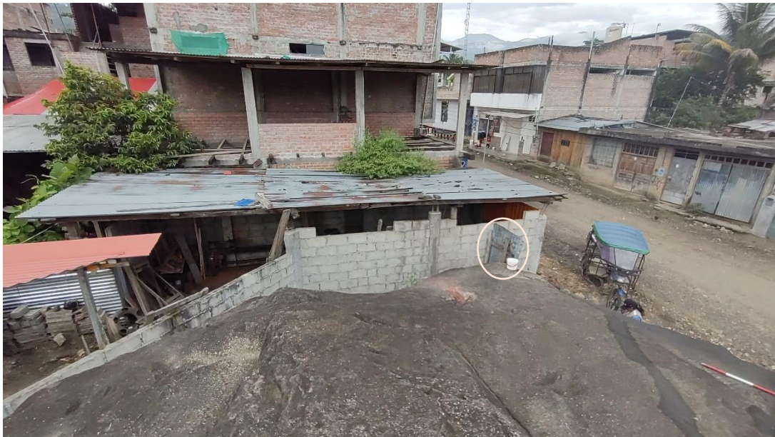
Imagen 07: Muro de vivienda que circunscribe el lado oeste y sur de la evidencia pétrea. Nótese el acceso de material rústico adosado al lado oeste de la misma.
