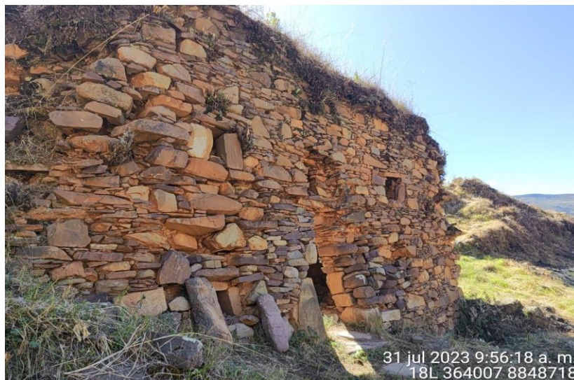
Imagen 02. Vista de la estructura denominada "La Capilla", durante la jornada de limpieza se cortó arbusto y hierbas que se encontraban pegadas a los paramentos.
