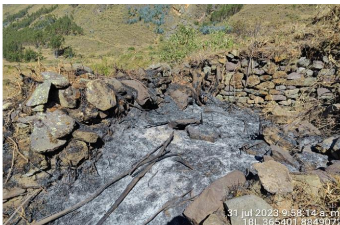
Imagen 04: Vista de una de las estructuras donde se quemó las hierbas, generando afectación en material pétreo y mortero.
