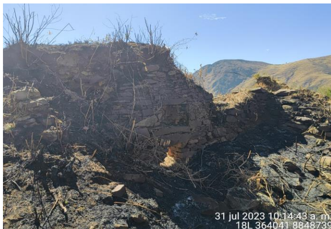
Imagen 05: Vista de una estructura quemada producto de la inadecuada jornada de limpieza realizada en el lugar. Nótese áreas de quema negra y piedras del paramento de color gris.
