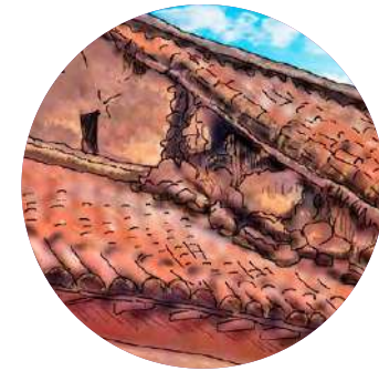
Desprendimiento del adobe
