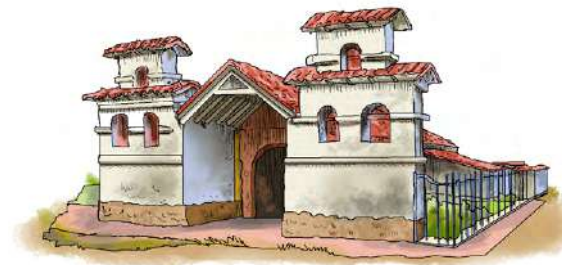
Capilla de la Inmaculada Concepción de Pachar. Ollantaytambo. Urubamba. Cusco. Antes y después de su restauración.
