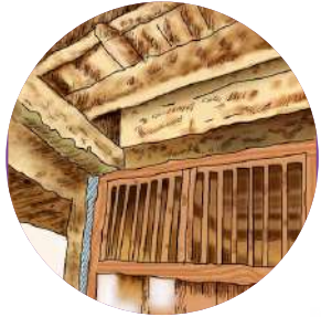
3. Deformación de estructura por humedad
