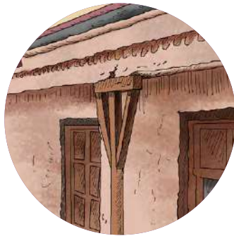
Apuntalamiento de muros para evitar su desplome
