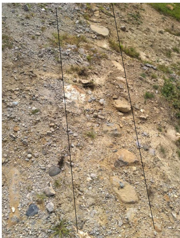
10. DETALLE DEL MURO CUBIERTO POR EL MATERIAL EXCEDENTE
