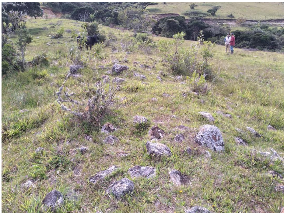
3. OTRA VISTA DE CABERA DE MURO CUBIERTA POR LA VEGETACIÓN
