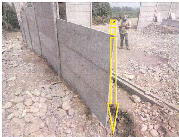
Foto 02: conjunto de muros ubicados en el extremo sur, con coordenadas 18l 208946 E/ 8821073 N, en base a placas y columnas de fibracemento, se observa la remoción de tierra para la instalación de las columnas.
