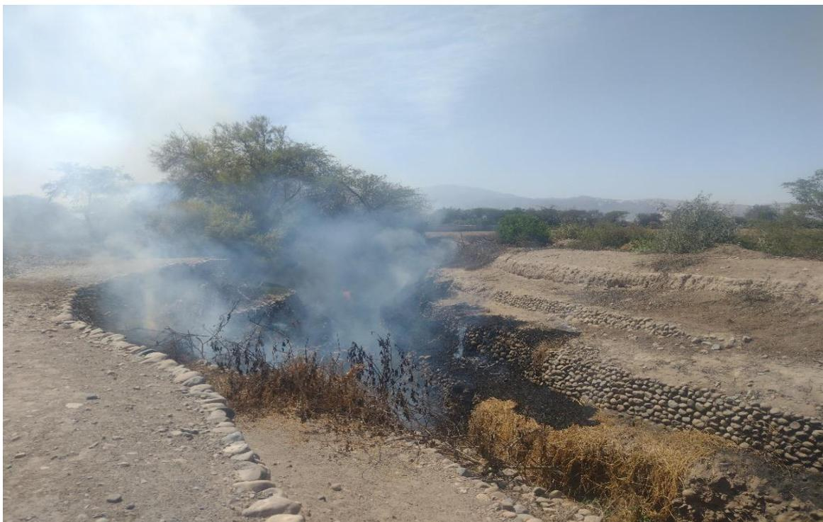
**Fig.03:** Véase la quema de malezas en el interior del canal tajo abierto del acueducto por parte de la junta de irrigación del sector de Ocongalla, esta mala praxis viene afectando sistemáticamente al Acueducto.
