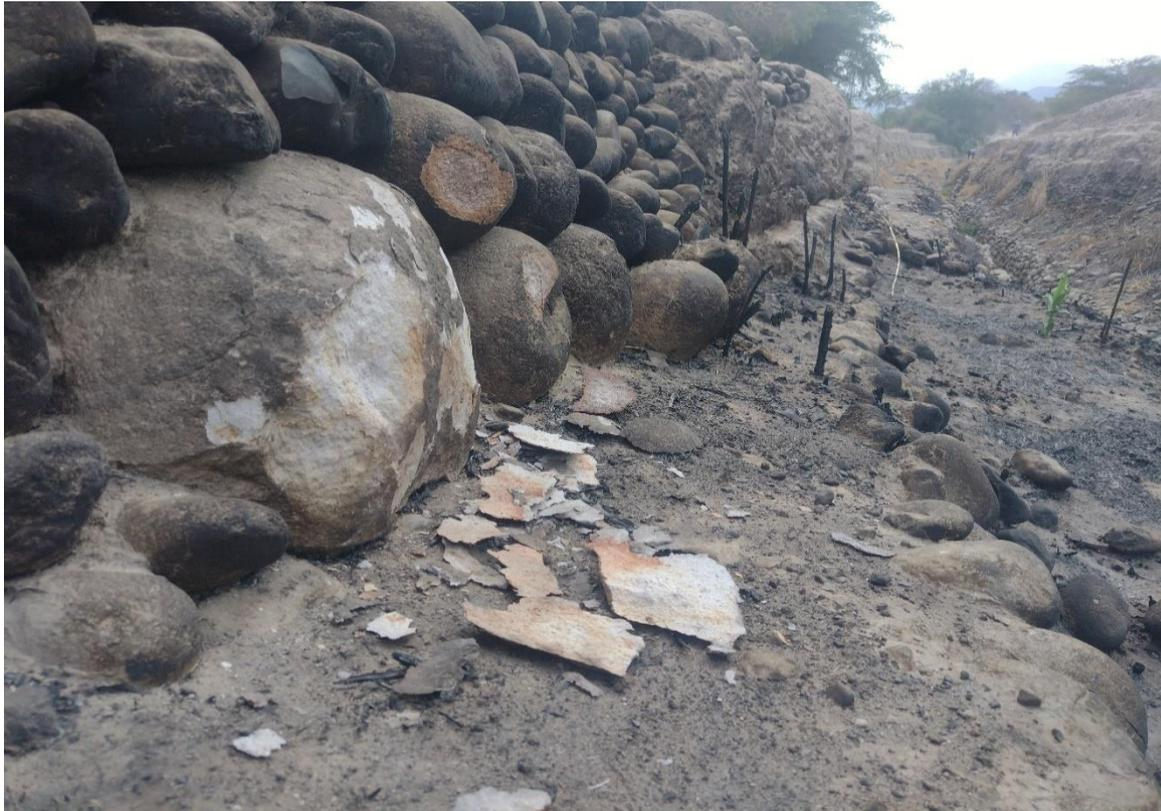
**Fig.04:** véase los cantos rodados termo-fracturados producto de la quema de carrizos y malezas en el canal tajo abierto del acueducto de Ocongalla.
