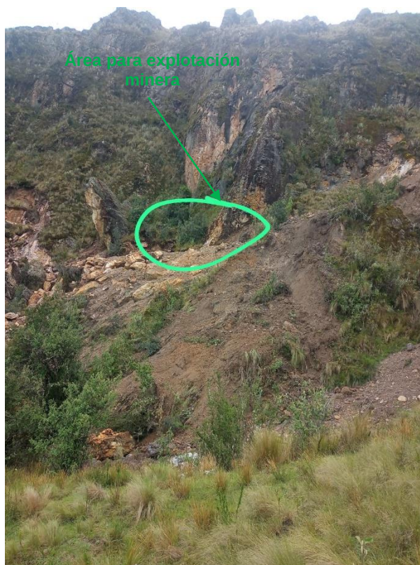
Fig. N° 10. Vista Panorámica de un área habilitada para la explotación minera. No se registra evidencia cultural en el perfil y superficie, por lo que no hay afectación al Patrimonio Cultural de La Nación. Sin embargo, si se continúa con los trabajos sin autorizaciones se podría afectar evidencias arqueológicas pertenecientes al Sitio Arqueológico "Huaylio".
