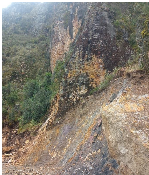
Fig. N° 09. Vista Panorámica de un área habilitada para la explotación minera. No se registra evidencia cultural en el perfil y superficie, por lo que no hay afectación al Patrimonio Cultural de La Nación. Sin embargo, si se continúa con los trabajos sin autorizaciones se podría afectar evidencias arqueológicas pertenecientes al Sitio Arqueológico "Huaylio".
