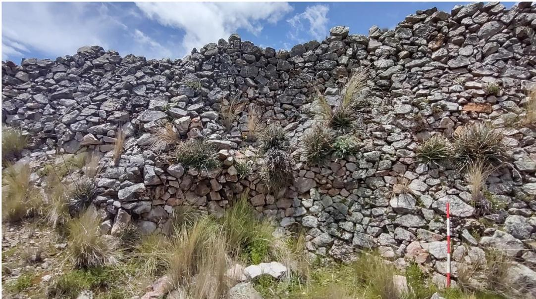
**Imagen 08:** Detalle del paramento externo del muro de contención. Nótese la mampostería y altura del muro.
