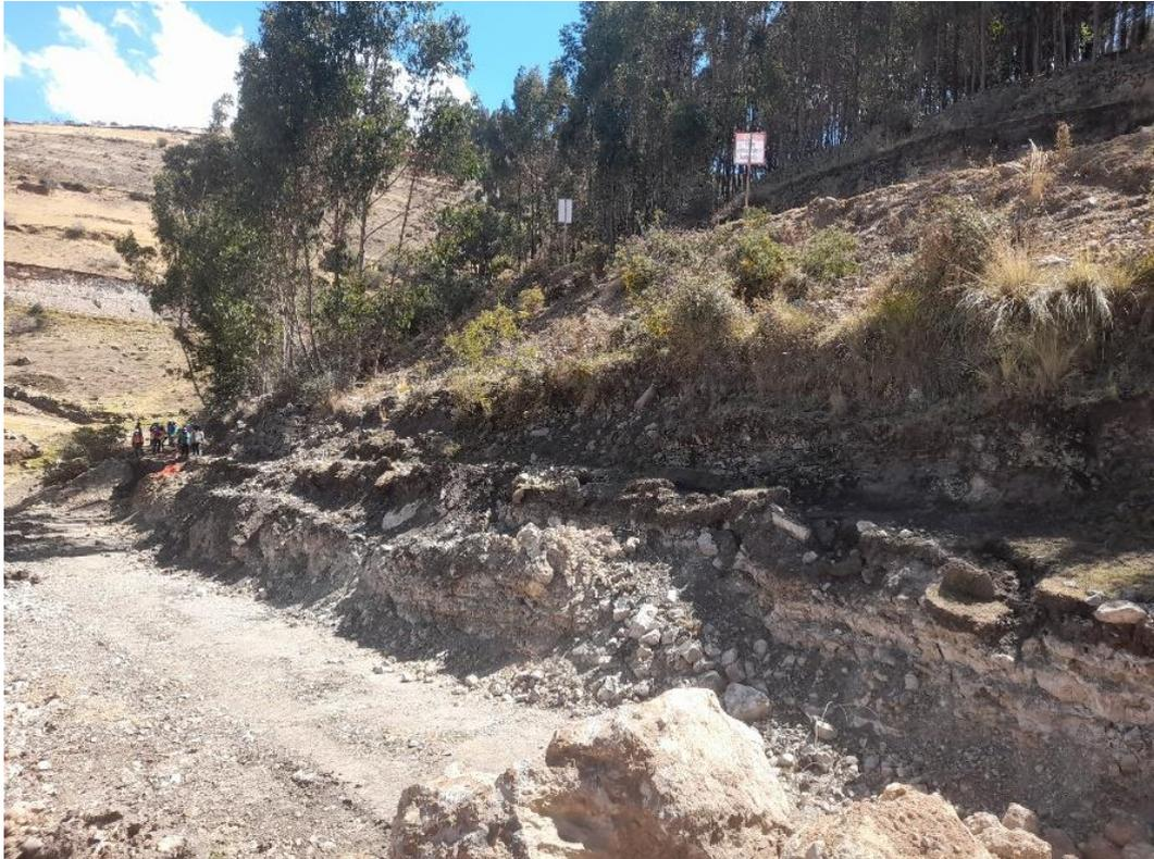
Imagen 9. Vista general del Punto de afectación 2, donde se ha destruido más de la mitad del ancho del Segmento 2 (Vista O-E)
