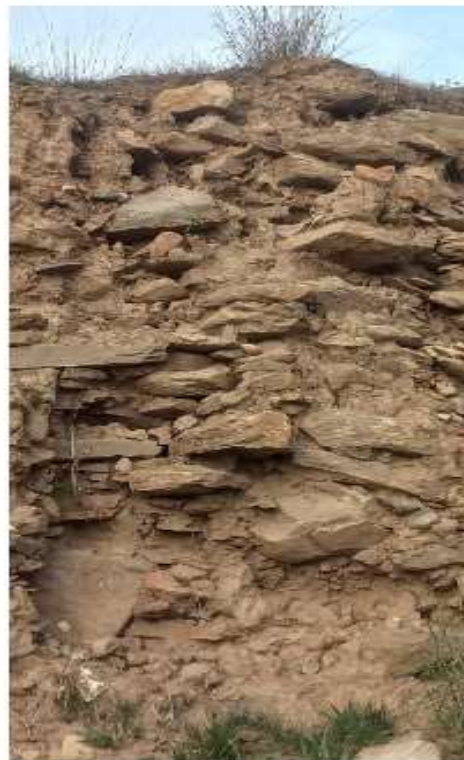
Foto 6: Perfil Sur otra parte del perfil donde se puede notar los muros Construido de lajas, expuestos
