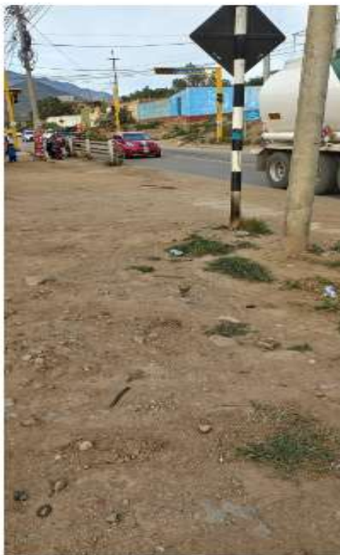
Foto 1: El montículo ha sido afectado quedando al nivel de la carretera
