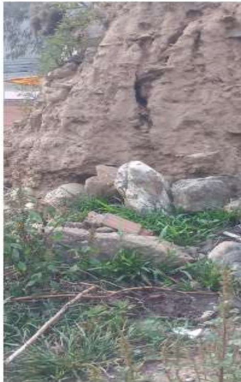
Foto 5: Perfil Sur otro ángulo donde se puede notar los muros expuestos en la parte superior impactado.
