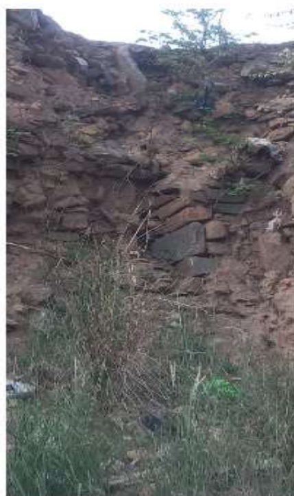
Foto 4: Perfil Sur se puede notar los muros en La parte superior impactado por la maquinaria pesada.
