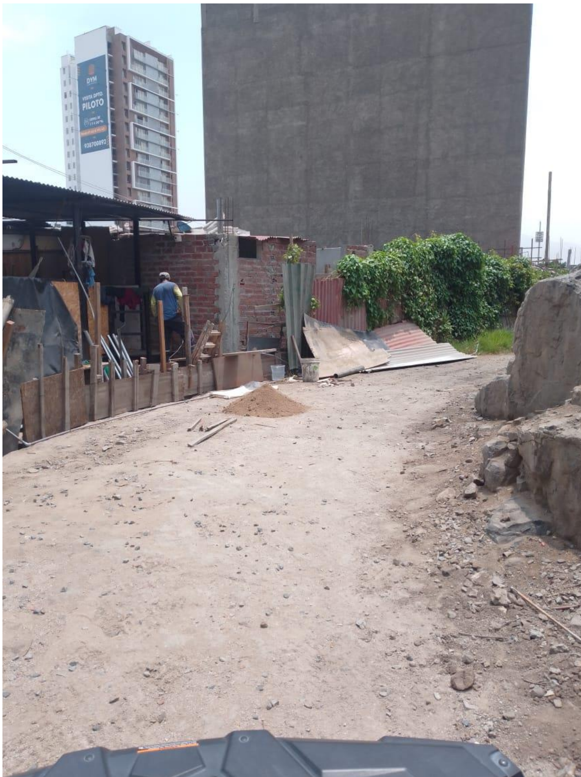
Vista de nueva construcción registrada el 17 de marzo del 2023, la cual se encuentra dentro del área delimitada.
