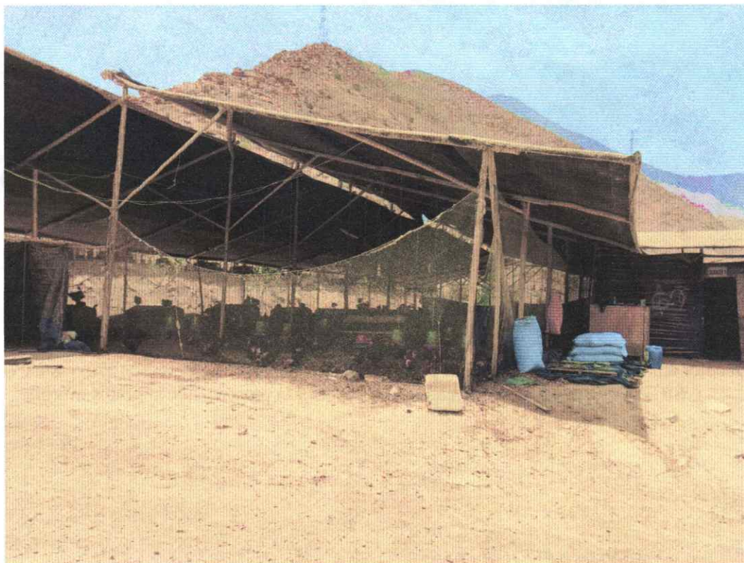
Vista de los galpones en uso, se puede apreciar los parantes “clavados” en el suelo para soportar la estructura del galpón
