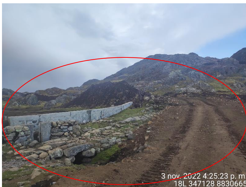
Foto N° 6: Detalle de los accesos desarrollados en el marco de la ejecución del proyecto "Extracción de Roca, el cual ha afectado la sección del camino prehispánico reconocido en la fotografía 1,
