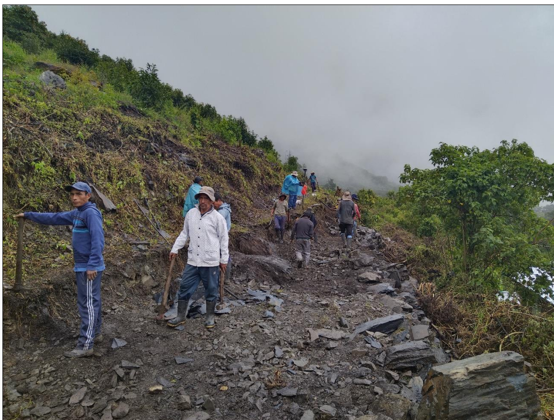
Vista donde se observa el movimiento de tierras para el ensanchamiento de la calzada del camino en el sector de Juyhuay
