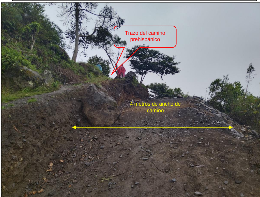
Vista donde se observa el trazo del camino afectado por la apertura de una trocha carrozable realizado de herramientas manuales, colindante al camino Tawis – Puente Ollanta.
