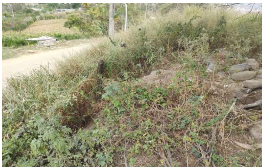
Foto N° 02.- Vista de la destrucción de elementos arquitectónicos del sitio Arqueológico San Isidro II".
