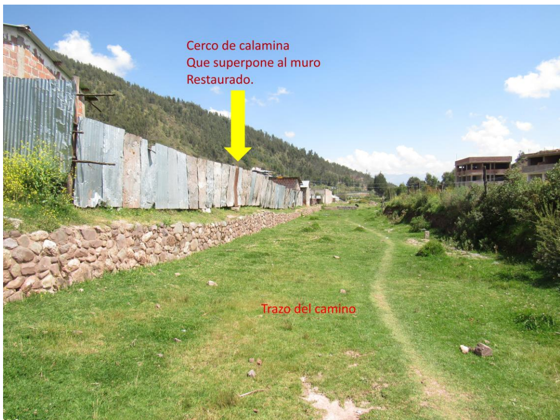
Vista del trazo del camino, en el segmento 7, donde se aprecia la colocación de calaminas sobre el muro restaurado.
