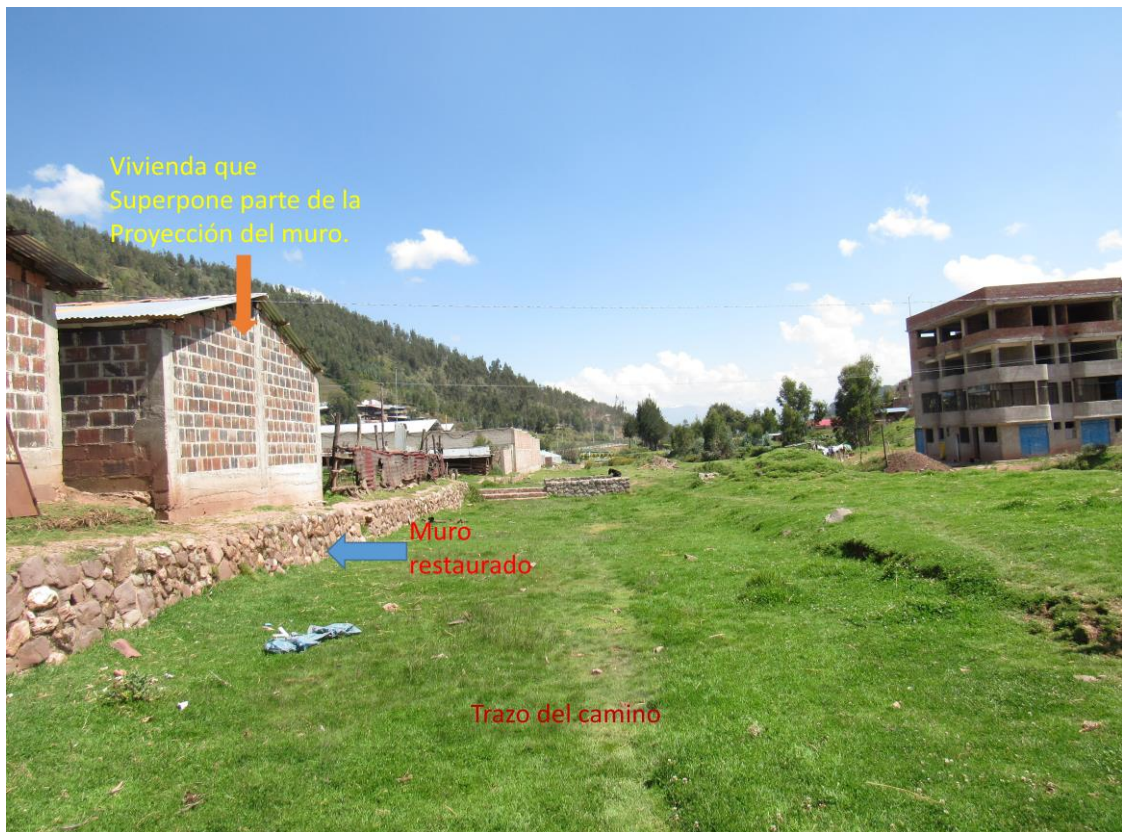
Vista del trazo del camino en el segmento 7, donde se aprecia la construcción de una vivienda que superpone la proyección del muro restaurado.
