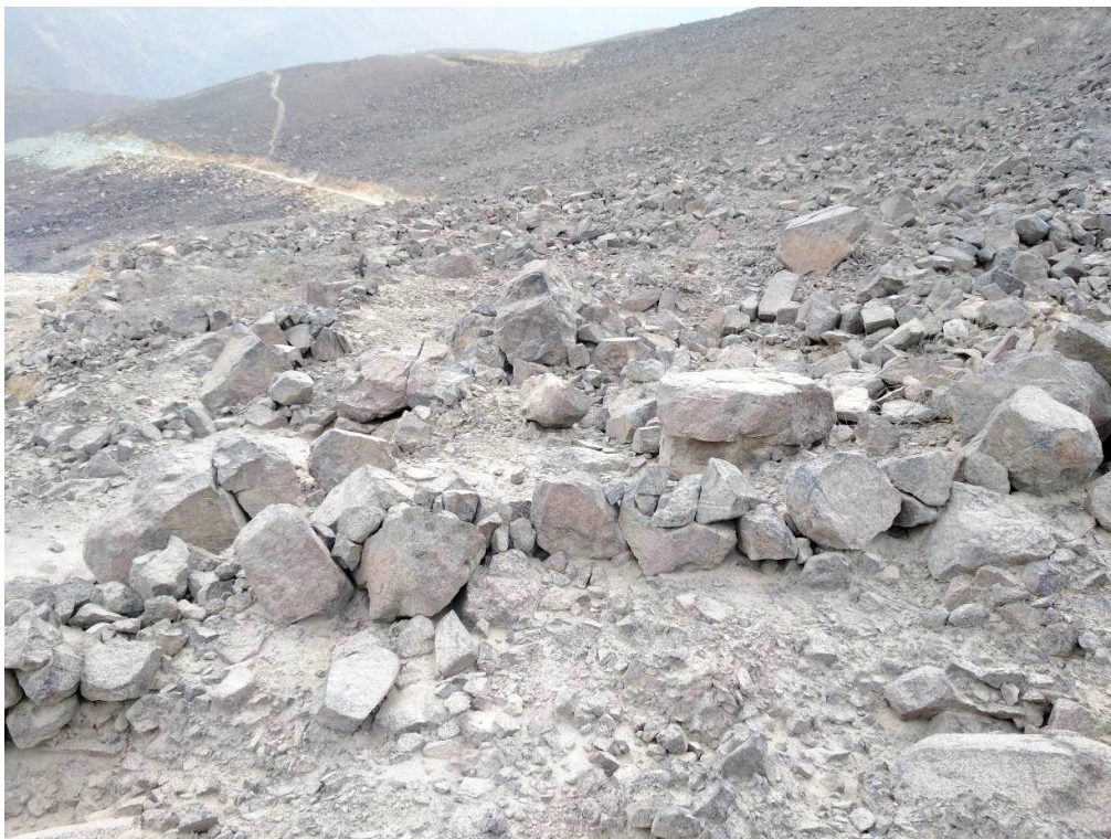
Foto 3: detalle de una edificación en piedra.
