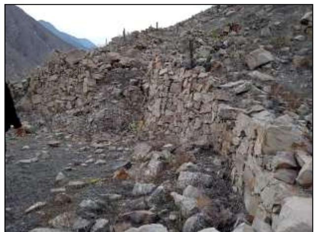
**Imagen 07.** Sector Sur. Muros de contención de terrazas.
