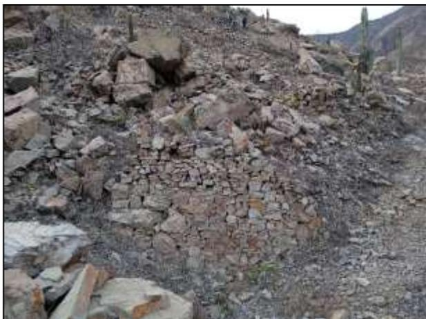
**Imagen 06.** Sector Sur. Muros de contención de terrazas.
