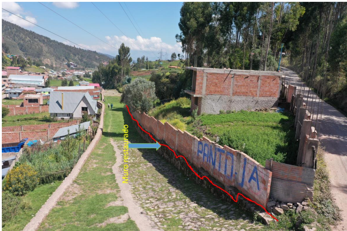
Vista del muro restaurado, que ha sido superpuesto por la construcción de un muro perimétrico, con materiales contemporáneos que alteran la originalidad del camino.
