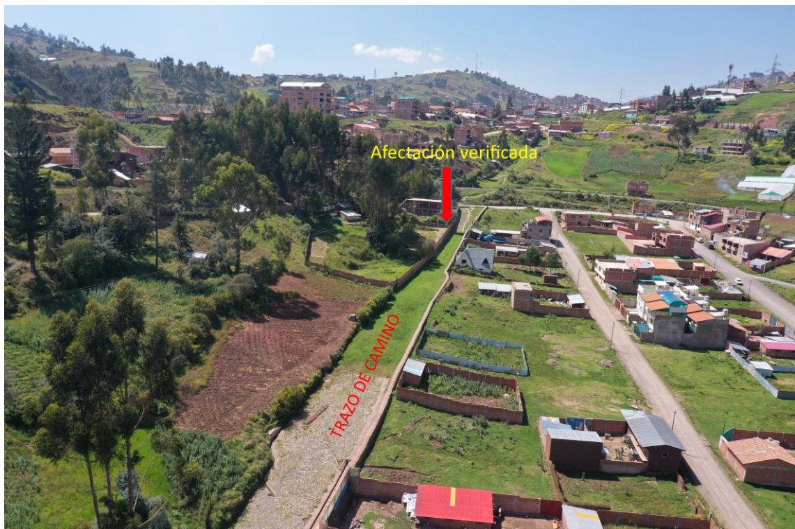
Vista panorámica del segmento 5, donde se puede apreciar las características del camino y la ubicación de la afectación.
