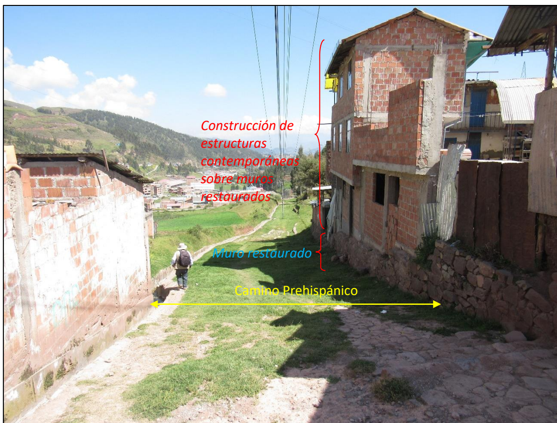
Vista donde se puede apreciar la construcción de nuevas estructuras de material de concreto sobre el muro restaurado por la DDC – Cusco.
