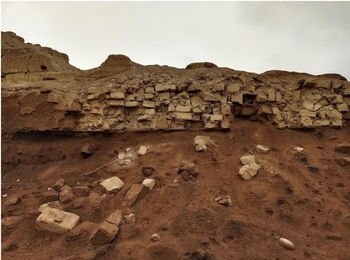
Fig. 9. Vista en detalle de un muro, el elemento basal de este muro está en el aire, a consecuencia de la humedad y las sales.
