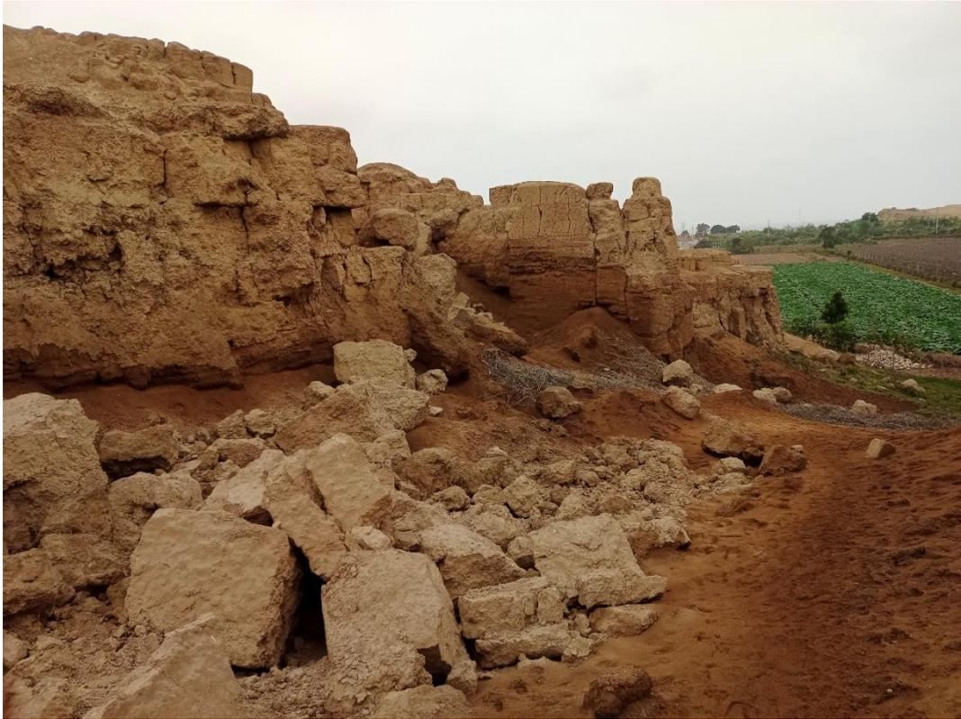
Fig. 10. Vista en detalle del colapso del muro en el lado sur, además de la activación de las sales a consecuencia de la humedad.
