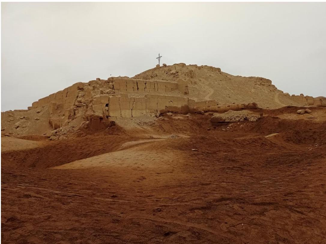
Fig. 8. Vista desde el lado noroeste, donde se aprecia la humedad que está avanzando hasta la parte media del sector ceremonial, además los muros están agrietados por los sismos y la acción de las sales.
