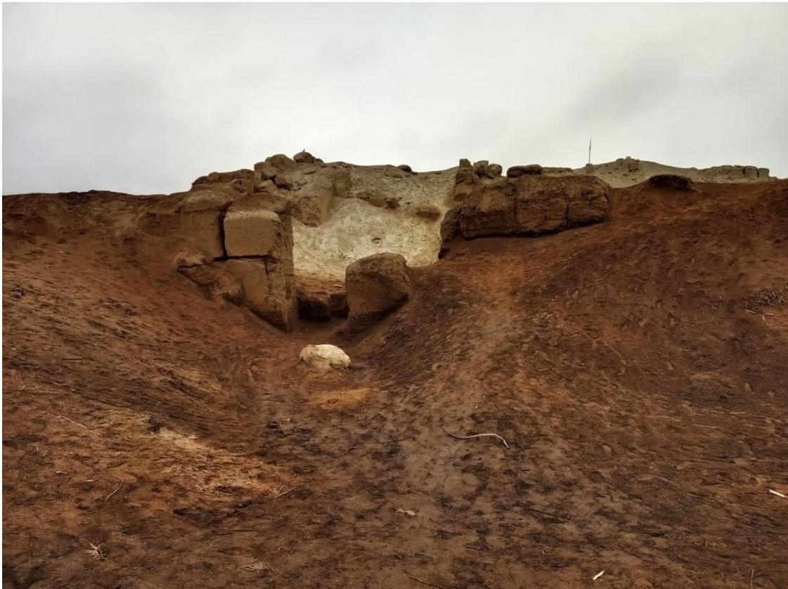
Fig. 3. Vista en detalle de la humedad en el sector noroeste, fíjese la magnitud de la humedad, que además está generando la activación de sales con ello los muros están a punto de colapsar.
