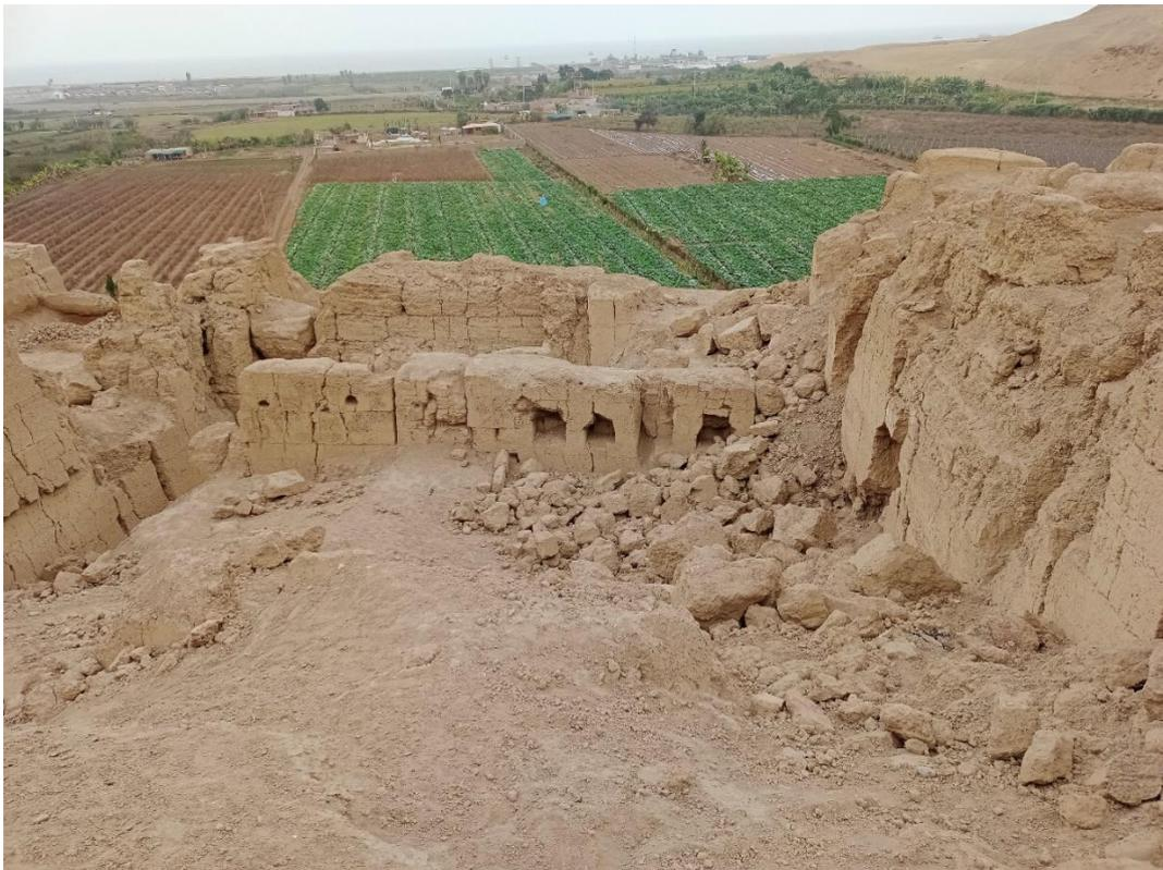
Fig. 12. Vista en detalle de los muros que habrían colapsado a consecuencia de los sismos ocurridos, lo que se requiere es el apuntalamiento.
