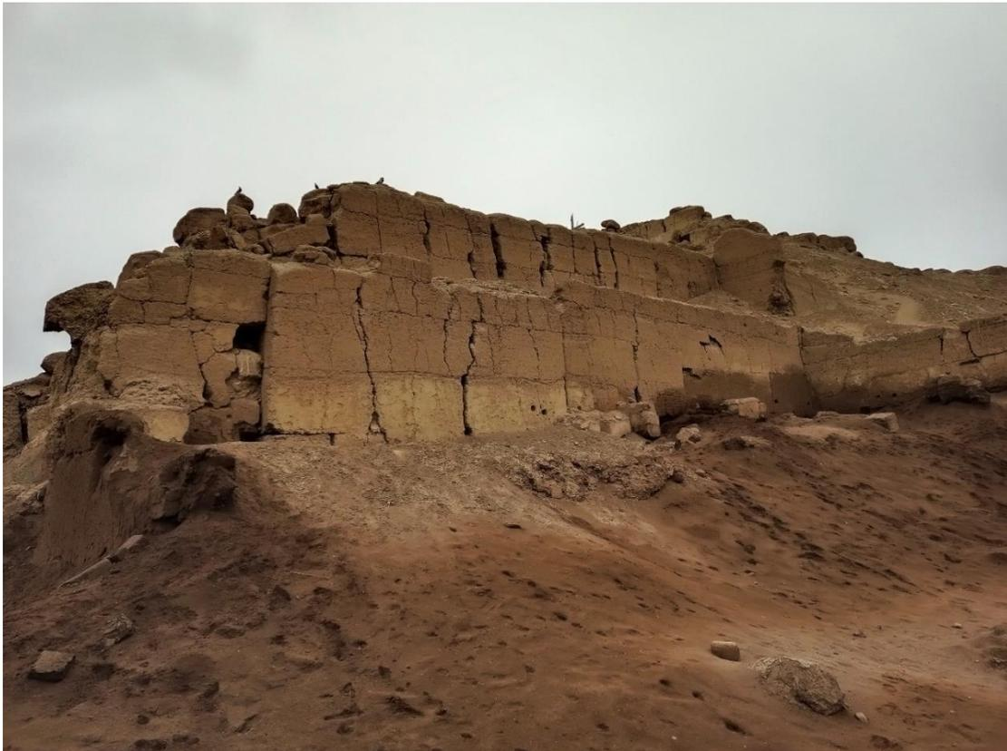
Fig. 9. Vista en detalle del muro a punto de colapsar, por lo que se requiere del apuntalamiento.
