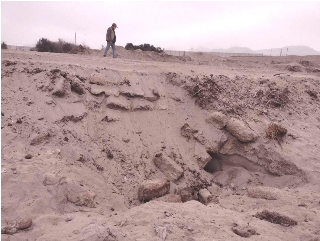
Foto 4. Detalle de uno de los muros de contención de champa, al lado Norte dl bordo.
