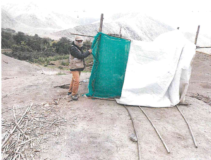
FOTO 4: CONSTRUCCIÓN RECIENTE DE UNA EDIFICACIÓN PRECARIA.
