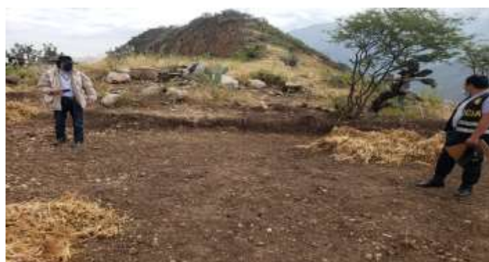
Fotos 1 y 2.- Construcción de represa y exposición de elementos arquitectónicos del sitio "El Antivo", por obras inconsultas. Constatación por la DDC- Cajamarca y la Policía Nacional.
