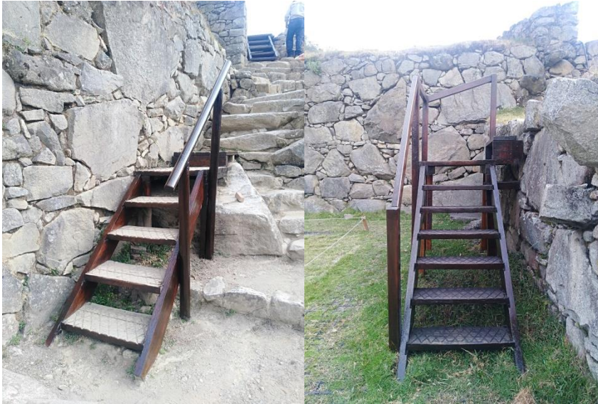
Figuras 2 y 3. Detalle de accesos de madera que tienen la finalidad de descongestionar el flujo turístico y evitar el deterioro de los elementos líticos.
