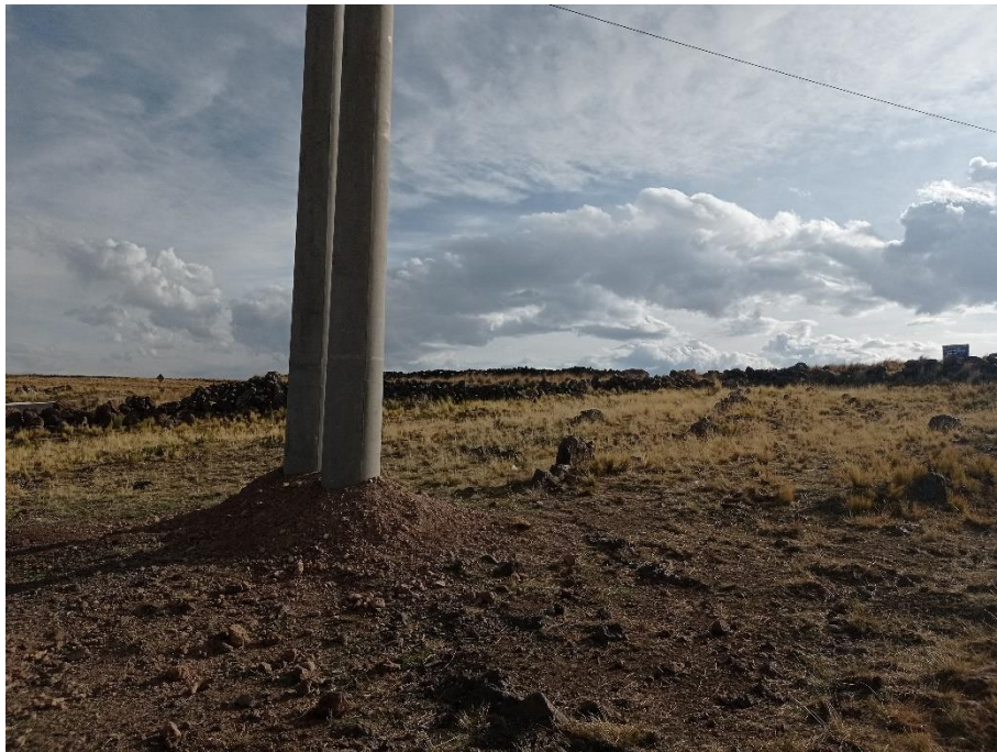
Detalle de afectación verificada – Instalación de postes en Julio de 2021.
