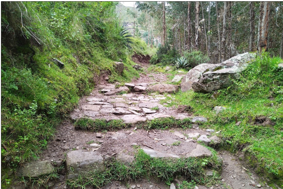
Vista donde se observa, un segmento de camino Huayqui – Acos, de tipo Empedrado con Escalinatas sin afectación.
