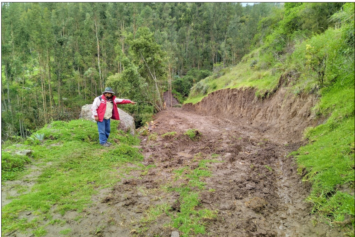
Vista donde se observa la apertura de una nueva trocha carrozable, el cual se superpone al trazo de camino.
