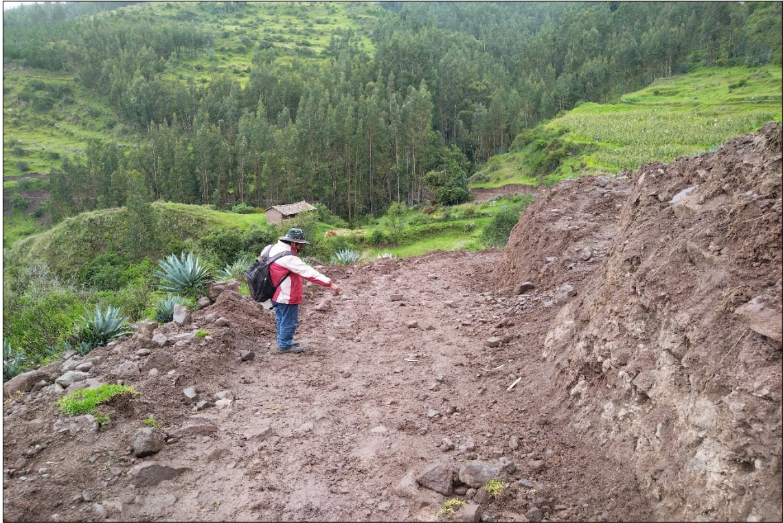
Vista donde se observa la apertura de una nueva trocha carrozable, en el cual se superpone al trazo de camino.
