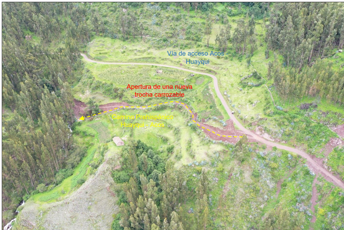
Imagen con DRONE del camino Huayqui – Acos, donde se observa la apertura de una nueva trocha carrozable sin autorización del Ministerio de Cultura, afectando los componentes formales del camino.
