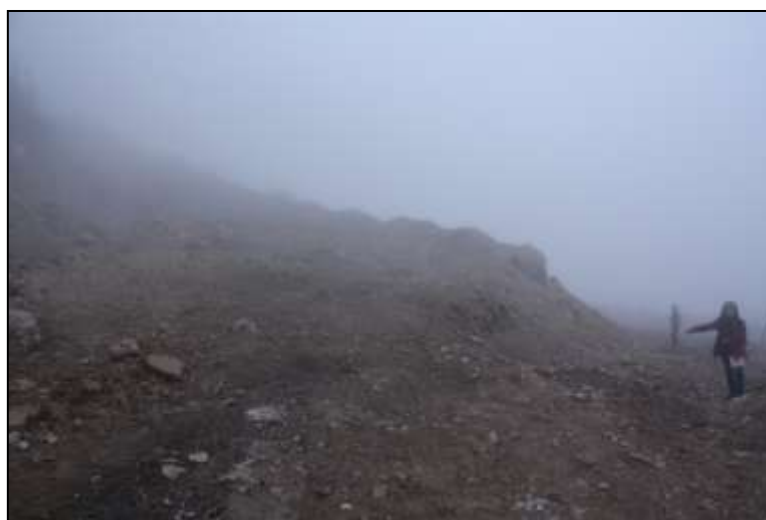
Imagen 03. Área de afectación al tramo cercano al Km 1212 del camino de herradura. Las excavaciones han destruido totalmente la evidencia arqueológica.
