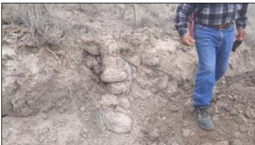
Imagen 08. Muros de andenería prehispánica expuestos y afectados por las excavaciones ilícitas.
