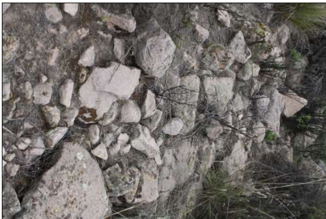
Imagen 02. Vista de base muro de doble paramento.
