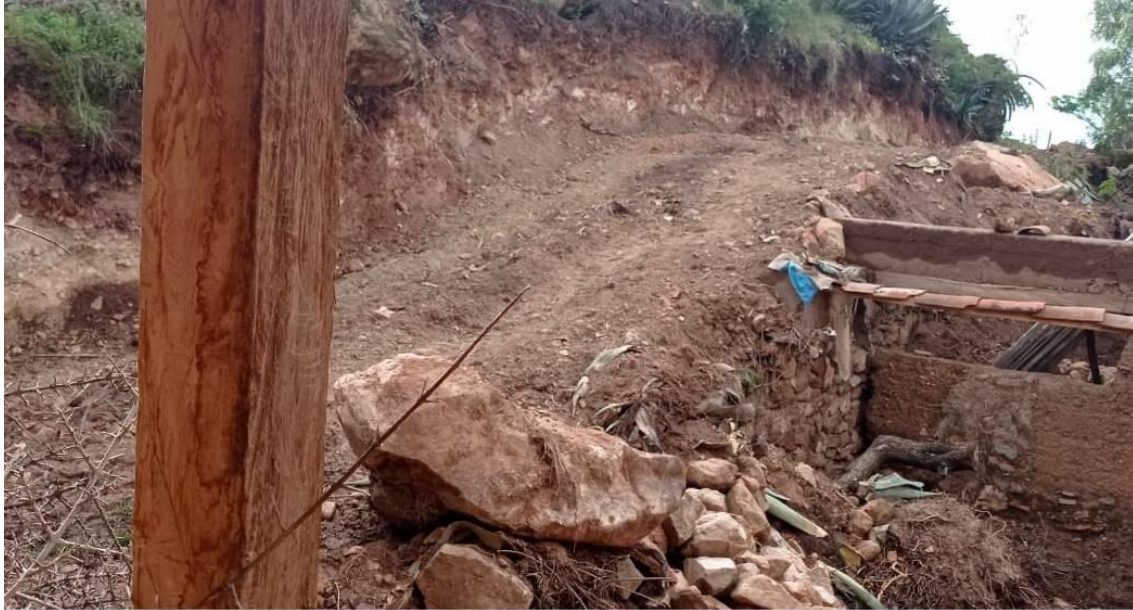
Foto N° 07.- Vista panorámica del área del sitio arqueológico Garajirca, donde se observa la intervención de maquinaria pesada, ubicado en el caserío de Santa Rosa de Chingas, en el distrito y provincia de Huacaybamba de la región Huánuco.
