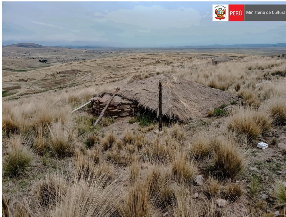
Imagen N° 22: Fotografía del colapso de la cobertura de paja de la chulpa en el sector II,
