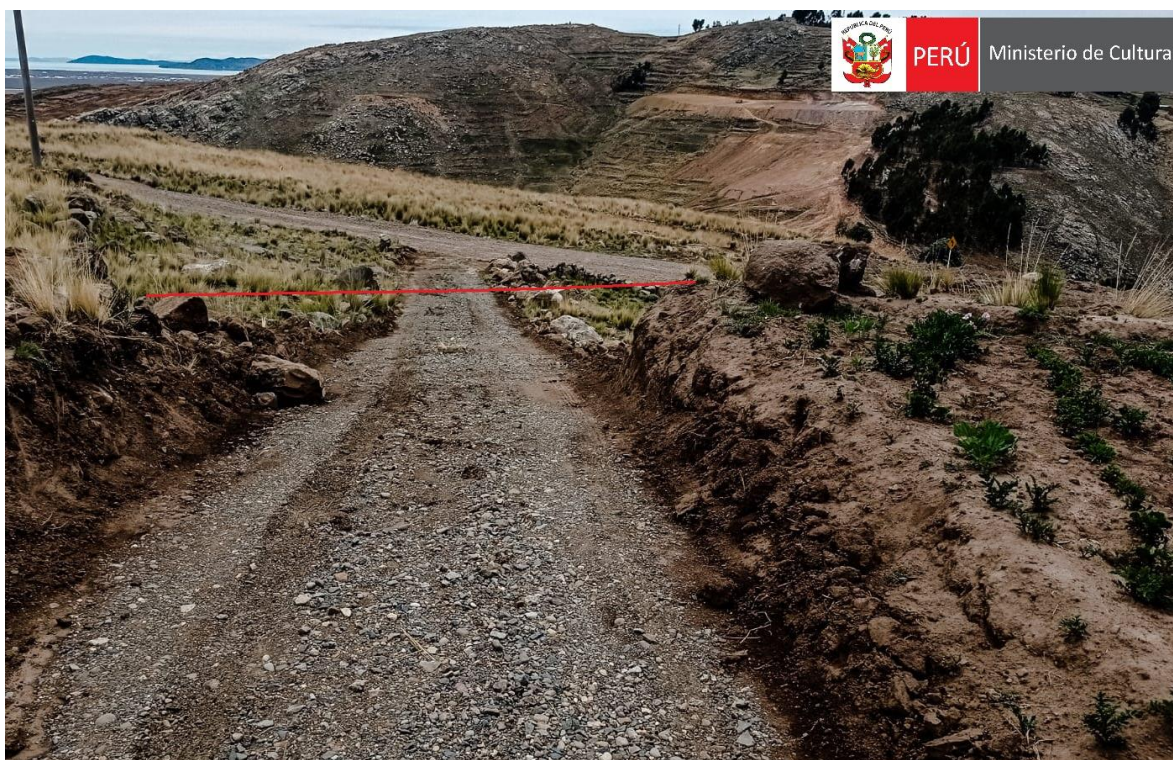
Imagen N° 38: Vista de la apertura de la trocha para el acceso hacia la vivienda en construcción, nótese la REMOCIÓN de un muro de contención y parte de la superficie de una terraza agrícola prehispánica,
