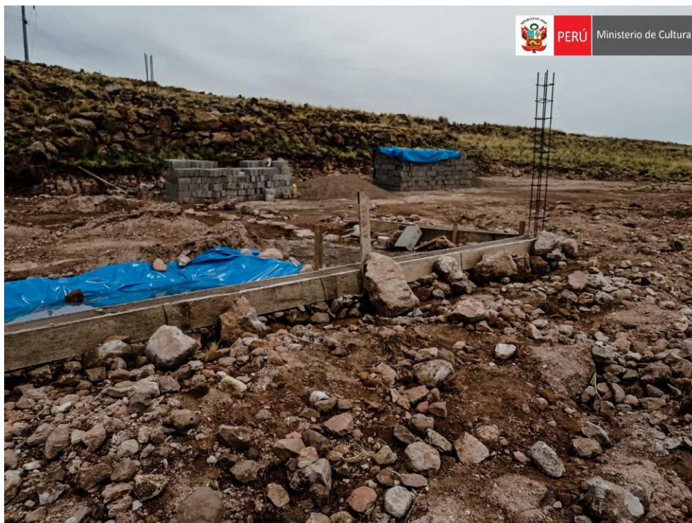
Imagen N° 36: Fotografía de los trabajos para la cimentación de la vivienda,
