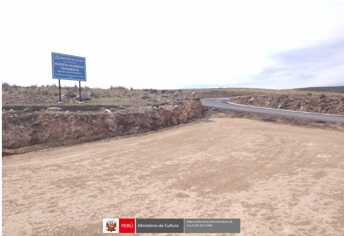
Imagen N° 28: Vista del panel informativo próximo a los trabajos que se realizan en la vía entre el sector I y II,
