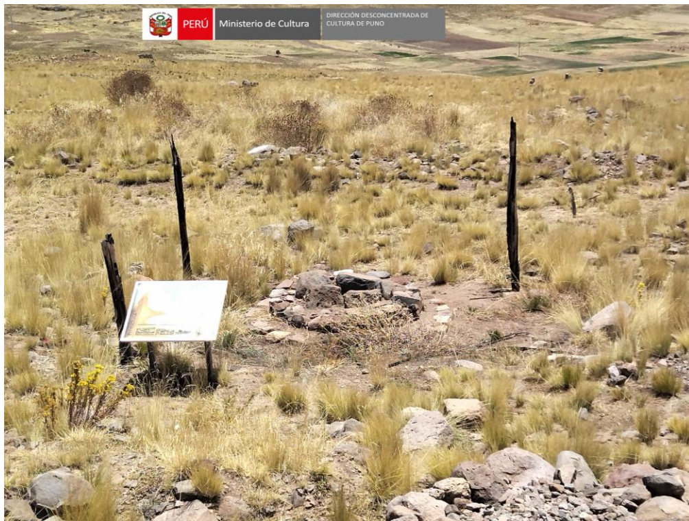
Imagen N° 25: Pérdida de la cobertura de paja producto del incendio ocurrido en el sector II,
