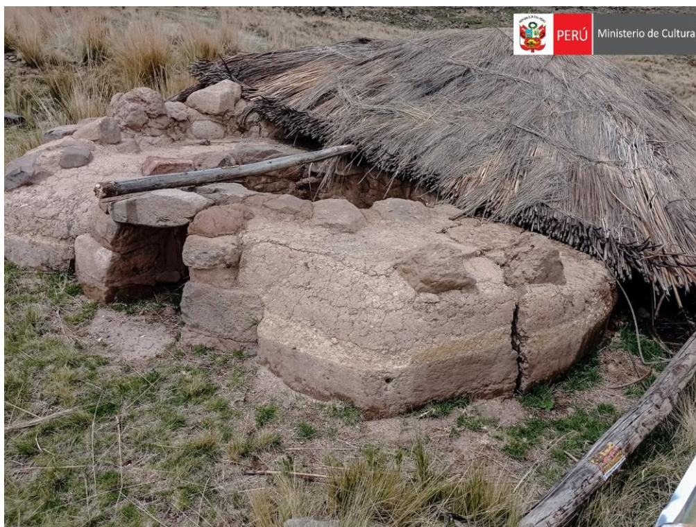
Imagen N° 23: Fotografía del colapso de la cobertura de paja de la chulpa en el sector II,
