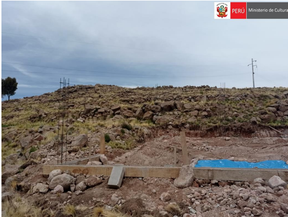
Imagen N° 35: Fotografía de los trabajos para la cimentación de la vivienda,
