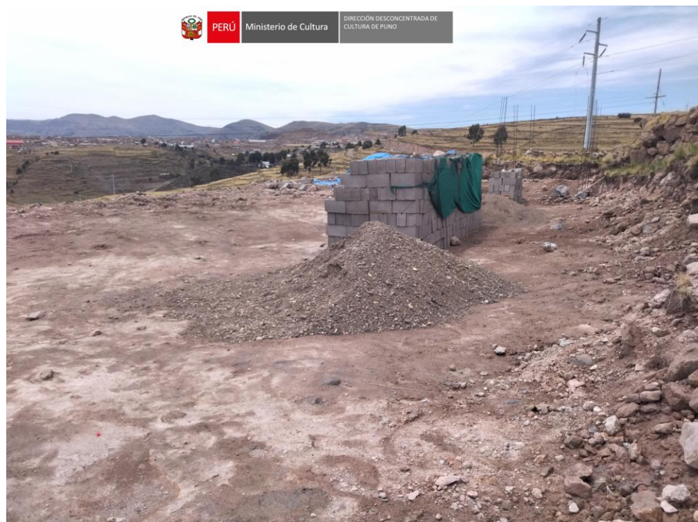
Imagen N° 35: Fotografía de los trabajos para la cimentación de la vivienda, obsérvese los materiales de construcción en superficie,
