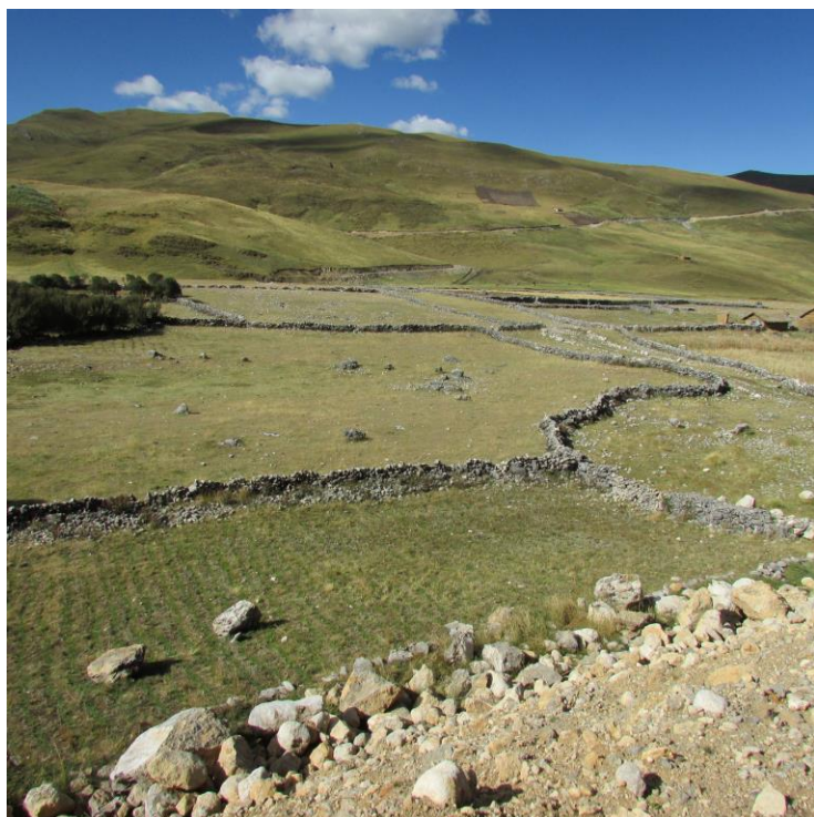
Foto 03. Vista de la tierra caída que cubre u segmento del camino inca.
