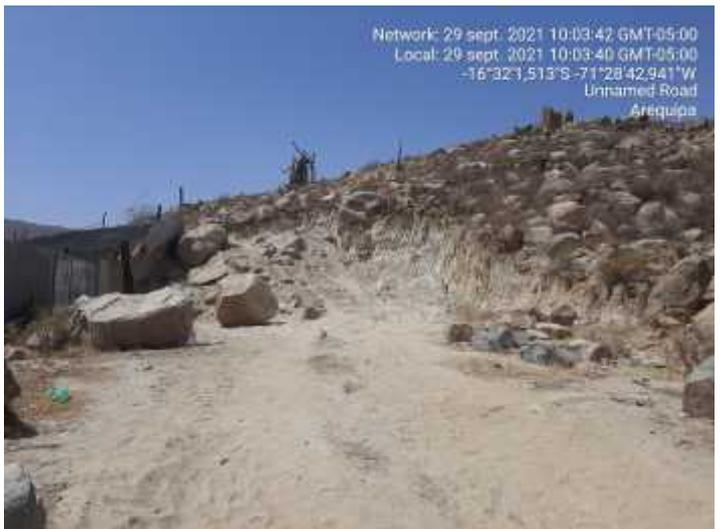
**Foto N° 02, vista fotográfica en la que se puede apreciar la remoción de suelos para la nivelación del terreno en espacios culturales.**
