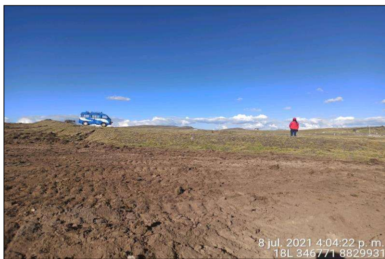
Imagen 12: Vista de detalle del área excavada por el Consorcio San Camilo. Orientación N-S.
