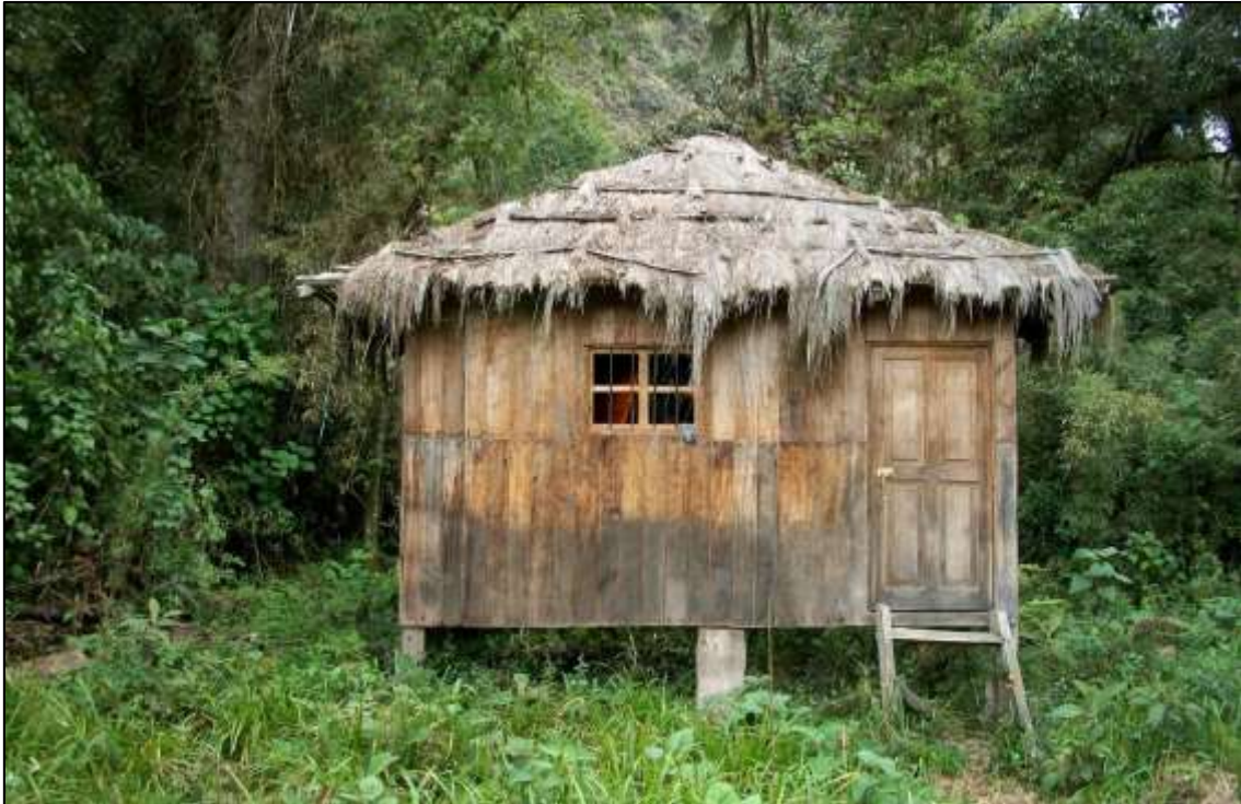
Figura 21. Pequeña caseta de madera (depósito) que el SERNANP mantiene en el sector La Playa del valle alto del Montecristo.
