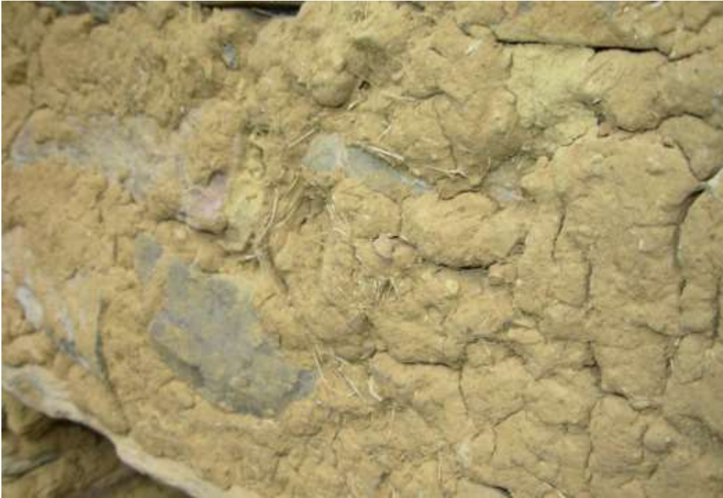
Figura 17. Foto del enlucido de la chullpa 4 de Los Pinchudos mostrando el craquelado y la paja incluida en la mezcla.
