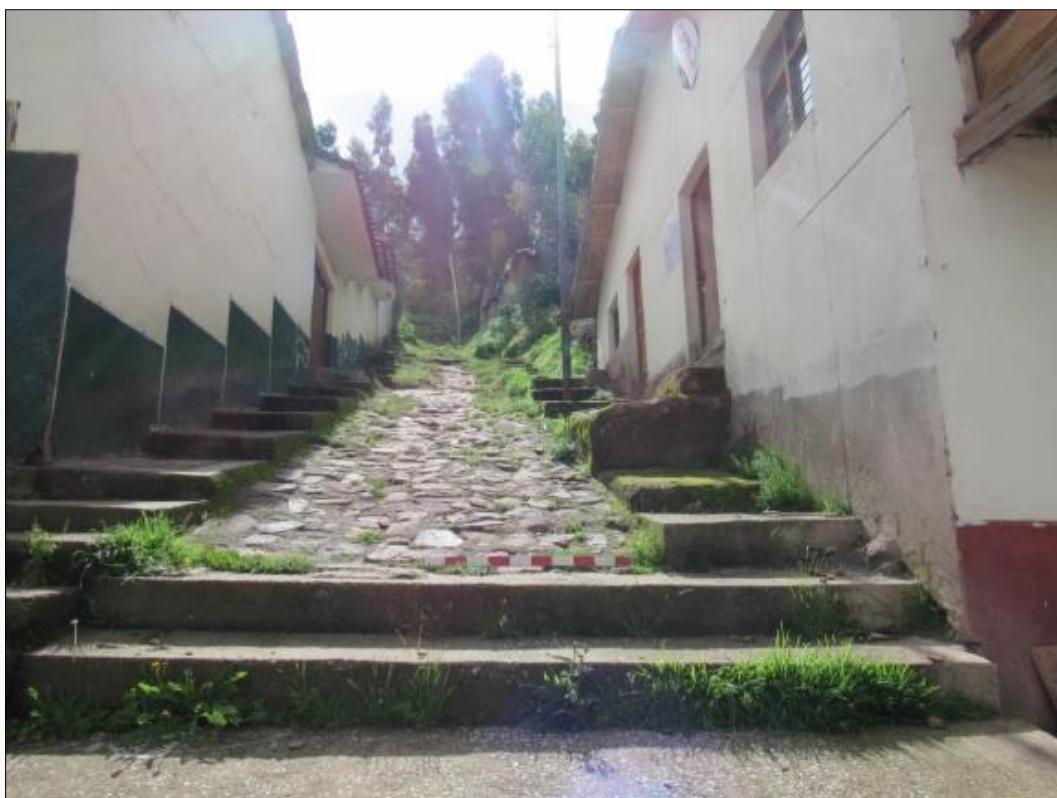
Vista panorámica del trazo del camino, que está siendo impactada por la construcción de viviendas próximos al camino en el sector de Ccorca.
