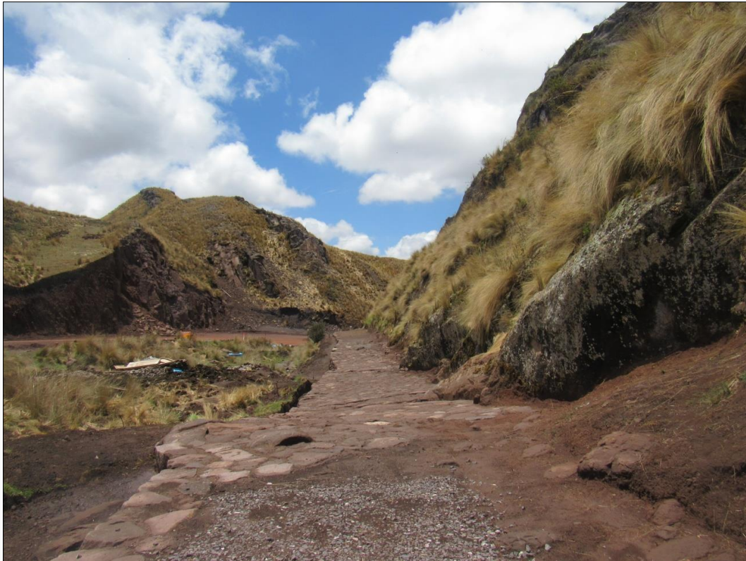
Vista del camino, caracterizado por presentar calzada empedrada y drenes transversales y verticales.
