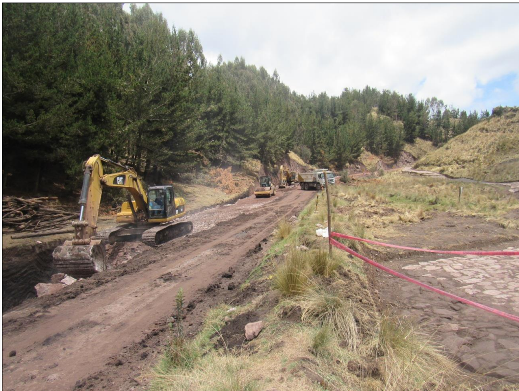
Vista de la construcción de una carretera, la misma que podría afectar la estabilidad de los componentes arquitectónicos del camino que están próximos.
