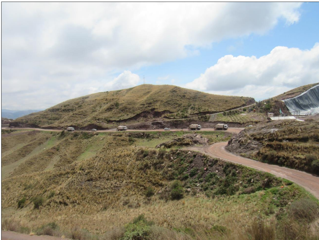
Vista de la ampliación de carretera para el traslado de residuos sólidos que está ubicado próximo al trazo del camino.
