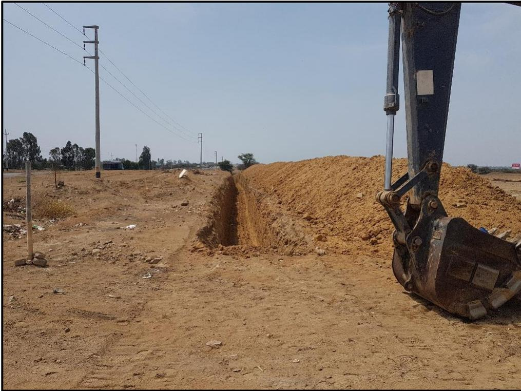
Foto06. La excavación de la zanja y la retroexcavadora con la que se realizó
