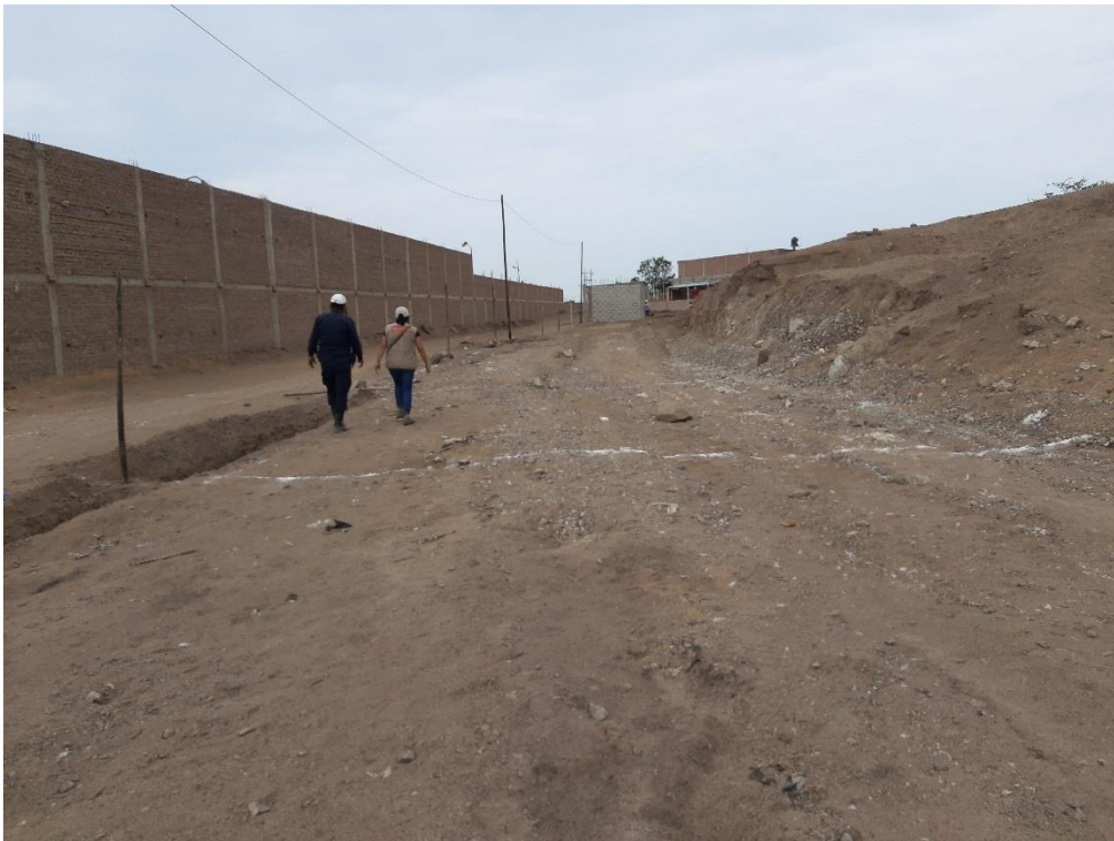
Fig. 04. Vista panorámica del área donde se vienen realizando las excavaciones de zanjas para la construcción de viviendas, así como el marcado con cal para la lotización del sector, actividades que se encuentran dentro del área conformante del Sitio Arqueológico "Farfán- Sector D", donde en superficie se ha registrado evidencias arqueológicas como fragmentos de cerámica.
