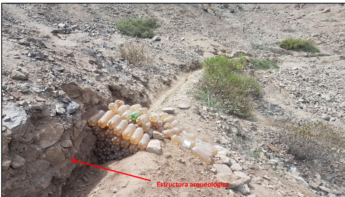
Foto 12. Excavación para realizar un canal de agua para alimentar al área de acondicionamiento agrícola y afectando estructuras arqueológicas. Afectación 5.
