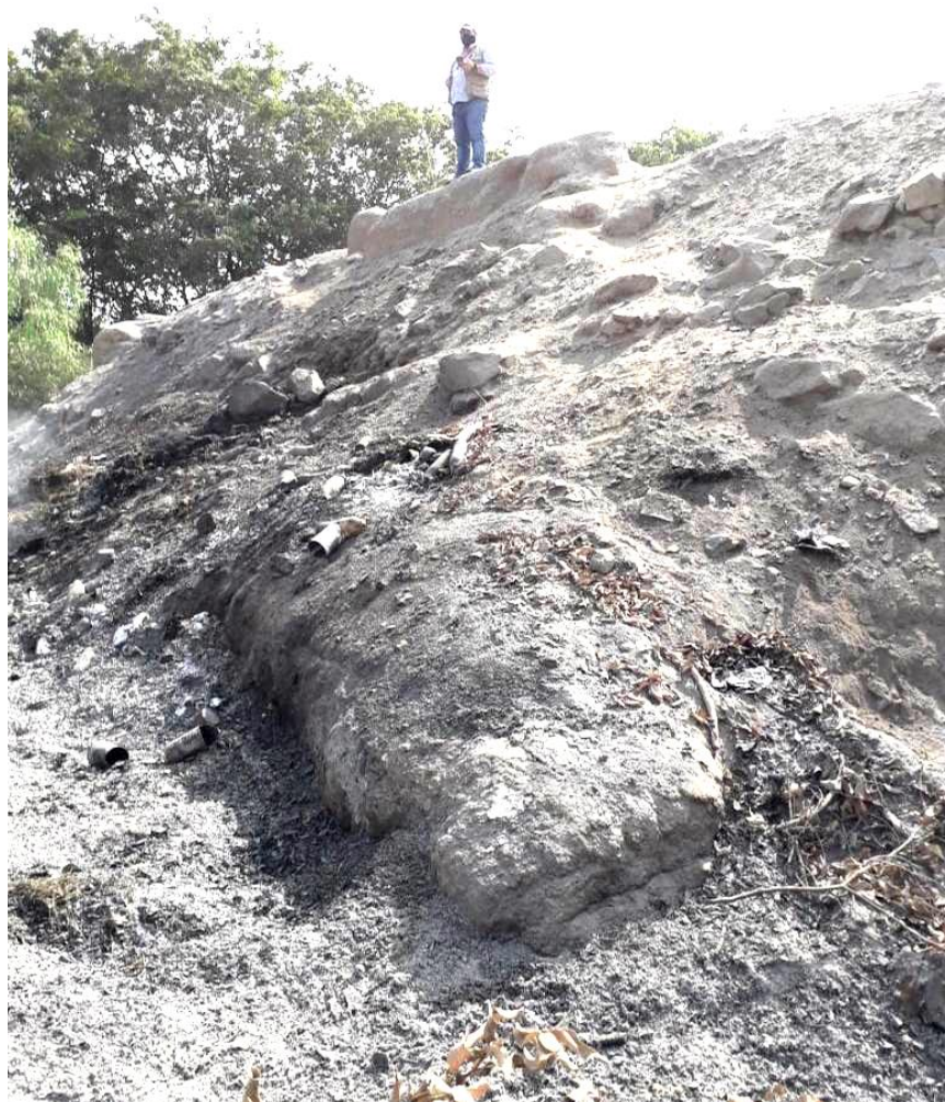
Detalle del área de la edificación piramidal alterada por el fuego, tizado y altas temperaturas.
