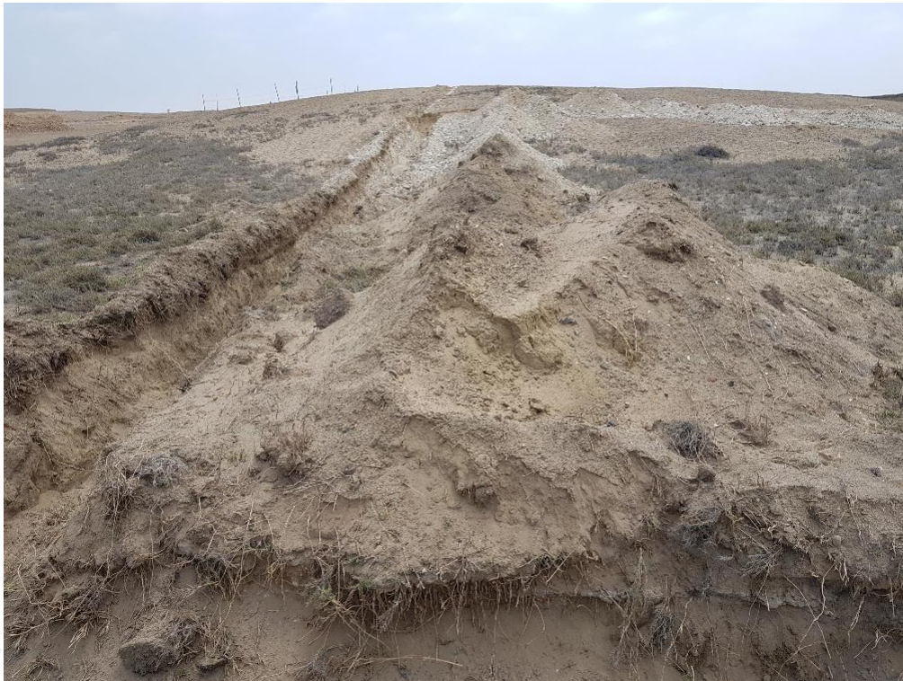
Foto02. Excavación de una zanja para la colocación de bases para la construcción de viviendas
