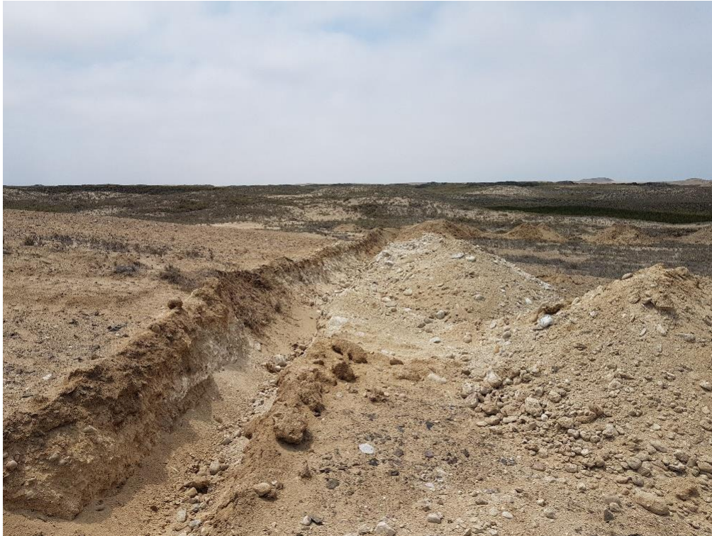
Foto 8. Zanjas para bases para la construcción de viviendas
