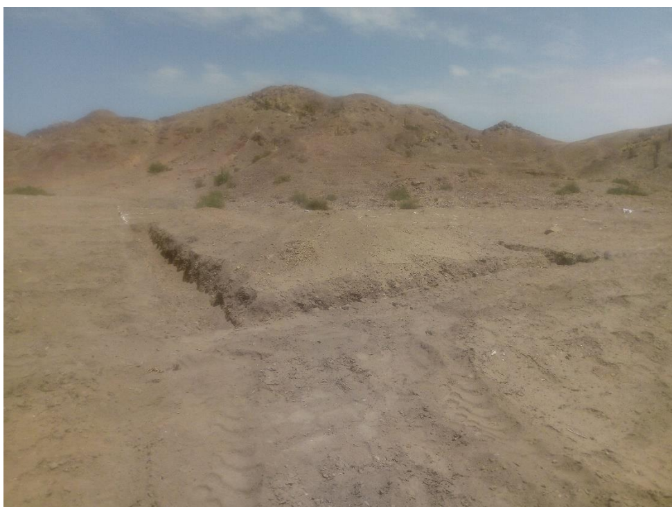
Imagen 06. Vista panorámica de las zanjas excavadas para algún tipo de construcción. Nótese que se encuentra asociada al área donde se ha intervenido con maquinaria pesada, donde a su vez se registran evidencias arqueológicas.
