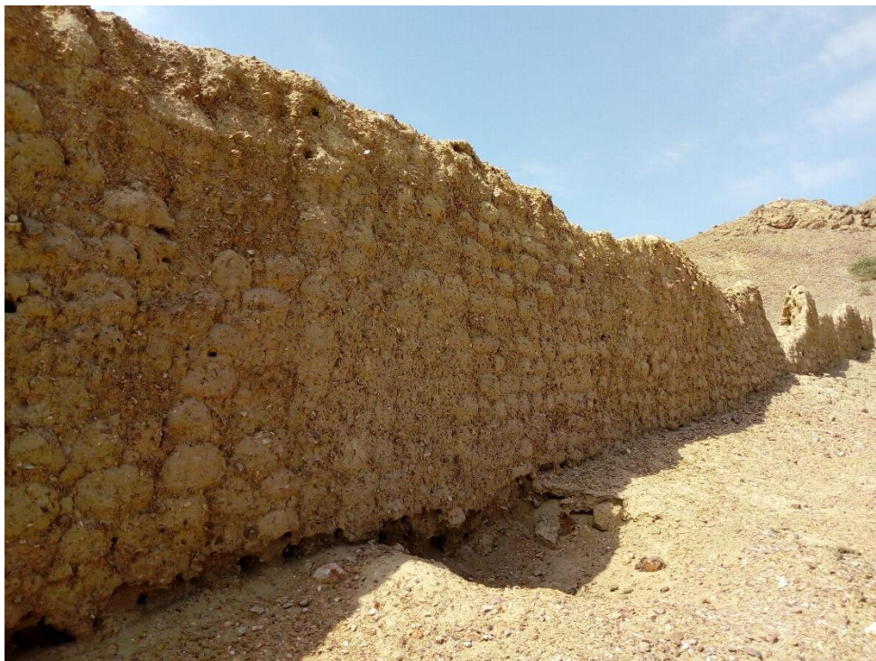
Imagen 12. Vista en detalle de uno de los muros que encierra a un posible patio o plaza. Nótese el abobe utilizado para su construcción, en mal estado de conservación.
