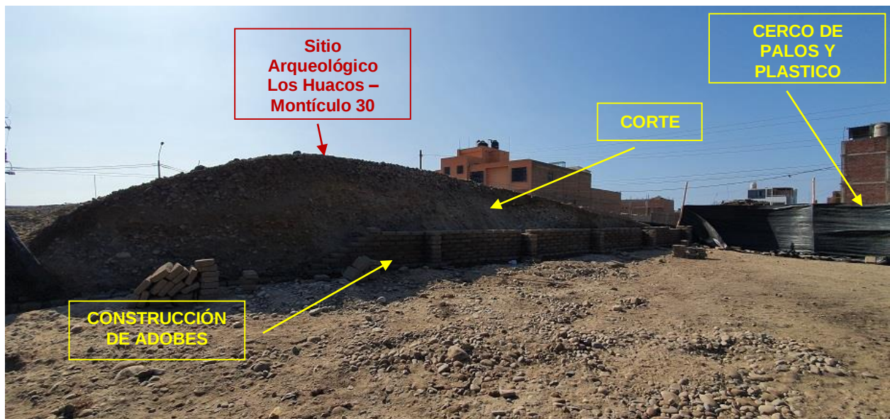
Foto 4: Sitio Arqueológico Los Huacos – Montículo 30. Vista en detalle del corte realizado al montículo para nivelar y posteriormente construir una estructura de adobes. Nótese el cerco de palos.
