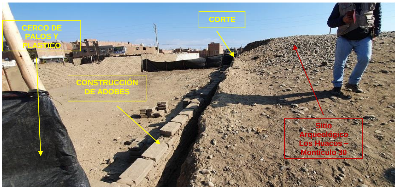
Foto 5: Sitio Arqueológico Los Huacos – Montículo 30. Vista en detalle del corte realizado al montículo para nivelar y posteriormente construir una estructura de adobes. Nótese el cerco de palos.
