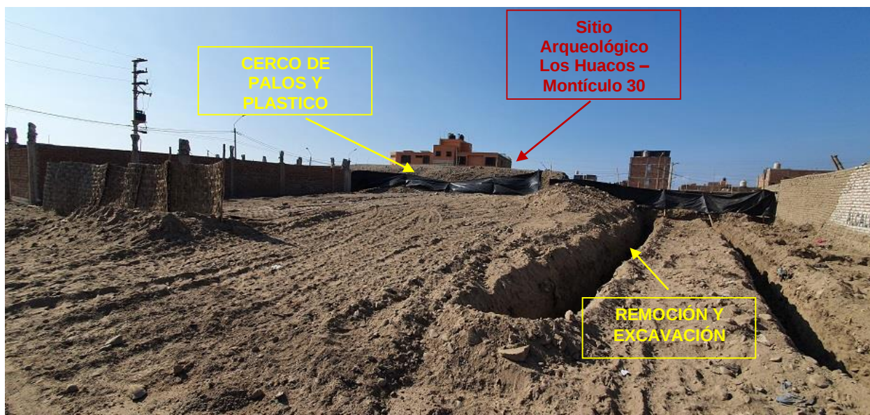
Foto 1: Sitio Arqueológico Los Huacos – Montículo 30. Vista panorámica, de las labores de excavación y remoción para nivelar y posteriormente asentar estructuras. Y nótese la construcción de un cerco de palos y plásticos que está encerrando el montículo arqueológico. Foto tomado el 02 de noviembre de 2020.
