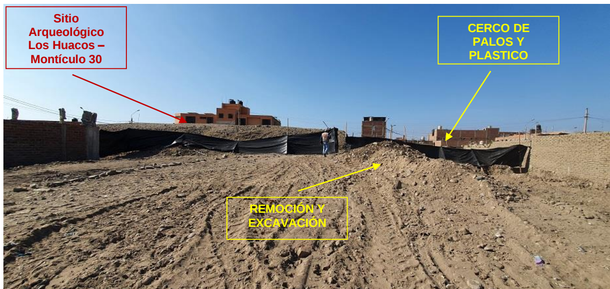
Foto 2: Sitio Arqueológico Los Huacos – Montículo 30. Vista en detalle del montículo cercado por postes y plástico. Además de las labores de excavación y remoción. Foto tomado el 02 de noviembre de 2020.
