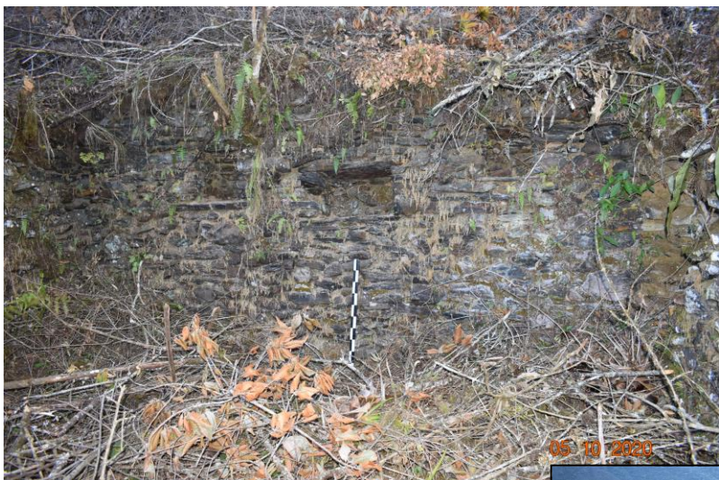
Imagen 09. Recinto que ha sido limpiado, nótese las hornacinas presentes en los muros.
