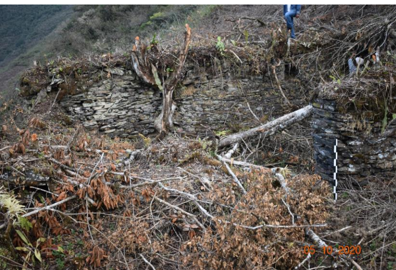
Imagen 08. Vista de uno de los uno de los recintos en el que ha caído árboles y arbustos afectando las estructuras.
