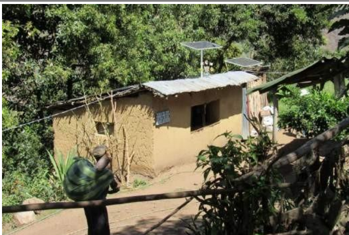
Foto 123: Detalle de una de las viviendas en sector Santa Rosa donde se expende alimentos al paso.
