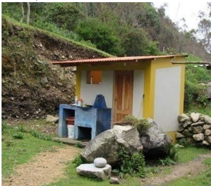
Foto 109: Módulo de letrinas e instalaciones sanitarias del saneamiento básico en Vilcabamba.
