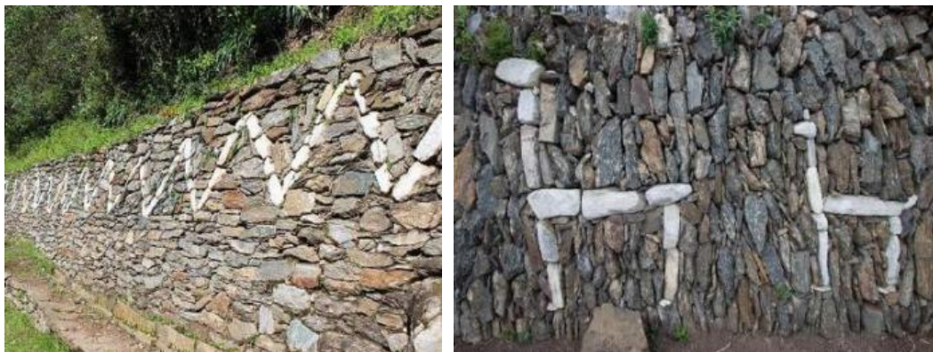
Fotos 99 y 100: Detalle de los diseños geométricos y zoomorfos en los muros de andenes con piedra de granito blanco.
