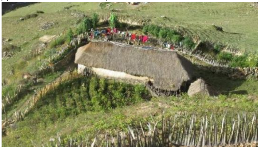
Foto 108: Vivienda rural en el distrito de Vilcabamba, sector de Yanawanka, en la construcción se emplea materia prima del lugar la cubierta se halla hecho por icchu, madera de qewña y bijujo, el enlucido de las paredes con arcilla amarilla, el cerco de la vivienda con hojas de puya.
