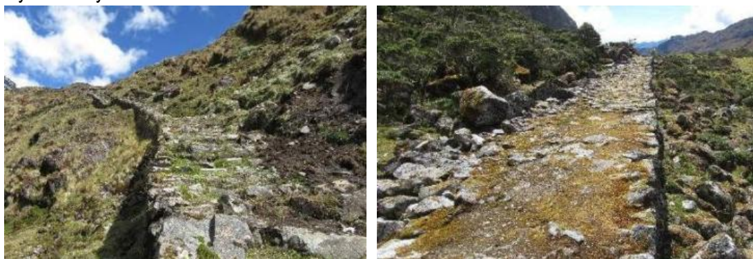
Fotos 68 y 69: Sección Inka Mach'ay a Samarinapata, camino con escalinatas y plataforma empedrada con muros de sostenimiento.
