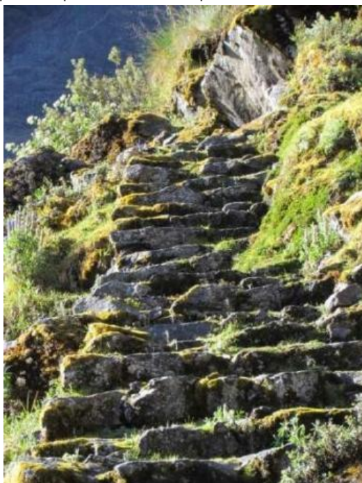
Fotos 09 y 10: La mayor longitud del camino en el tramo Vitkus – Choquequirao está construido con piedras de granito en tipología de escalinatas y plataforma empedrada con muro de sostenimiento de terraplén.
