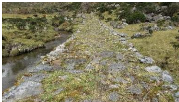
Fotos 72 y 73: Tipologías del camino en calzada elevada en desnivel y calzada empedrada en las partes llanas o espacios inundados, foto de sección Inka Mach'ay – Samarinapata.
