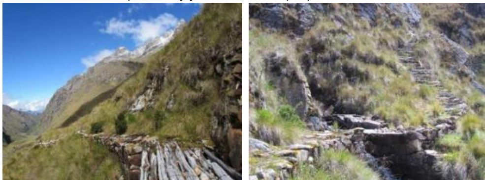
Fotos 77 y 78: Evidencias del camino prehispánico en el sector de Mandor y cerca Lazunapampa, hasta éste sector el camino ha sido restaurado en el año 2004 por el proyecto Qhapaq Ñan. Se observa el camino con escalinatas y acceso con pontones.
