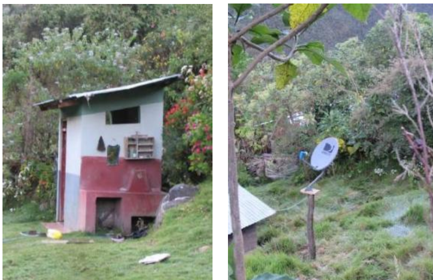
Fotos 116 y 117: Se aprecian los servicios básicos y de comunicación con los que cuenta el centro poblado.
