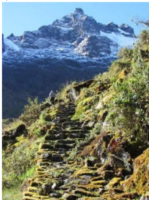
Fotos 09 y 10: La mayor longitud del camino en el tramo Vitkus – Choquequirao está construido con piedras de granito en tipología de escalinatas y plataforma empedrada con muro de sostenimiento de terraplén.
