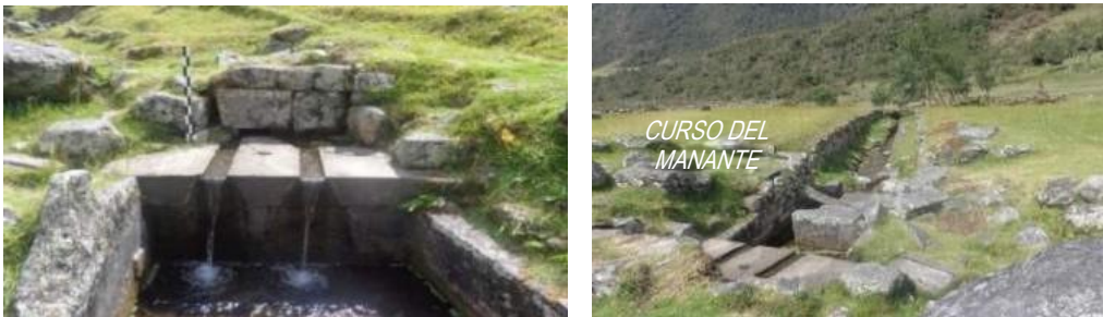
Fotos 59 y 60: Fuente de agua con canaletas talladas en la misma roca, el agua es conducida por un canal subterráneo y luego desciende por una canalización más amplia pasando por los andenes hasta el riachuelo que se encuentra próximo.
