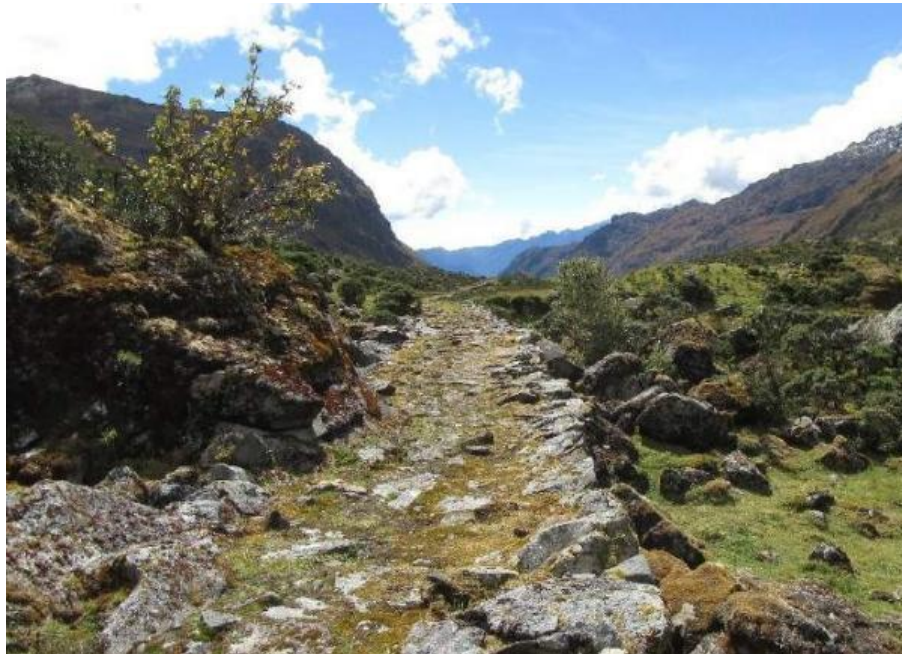
Foto 11: Camino en plataforma empedrada con muro de sostenimiento de terraplén en el sector de abra Qollpapampa, sección Inka Mach'ay – Samarinapata, fue restaurado en el año 2004 por el ex INC de Cusco.
