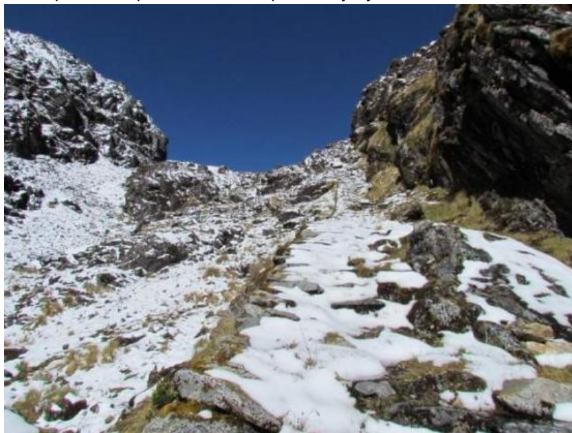
Foto 14: Camino empedrado con muro de sostenimiento en el sector de abra Choqetakarpu, tramo Vitkus – Vitkus, inscrita en la Lista del Patrimonio Mundial de la Humanidad por la UNESCO en el año 2014.
