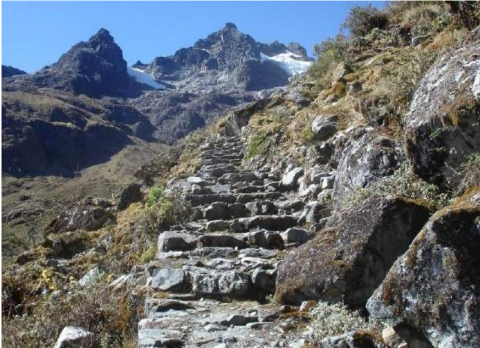
Foto 13: Se observa la tipología de camino con escalinatas en variante de pasos inclinados, las escalinatas se encuentran en terrenos inclinados con fuertes pendientes y la distancia de los pasos varían también según la forma del terreno. Foto sector Choqetakarpu, tramo Vitkus - Choquequirao.
