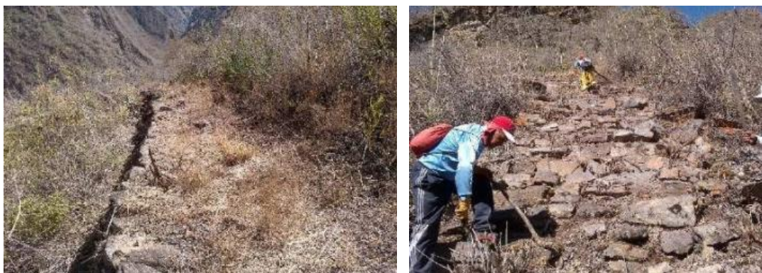
Fotos 83 y 84: Evidencias del camino prehispánico en la sección de Kutacoca a Choquequirao, su emplazamiento es por quebrada estrecha junto al bosque nativo de arbustos que afectan las estructuras del camino.
