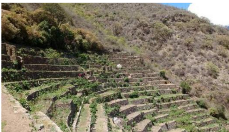
Foto 104: Andenes del sector Pinchaunuyoq, luego de la restauración se observan las plataformas conservadas.
