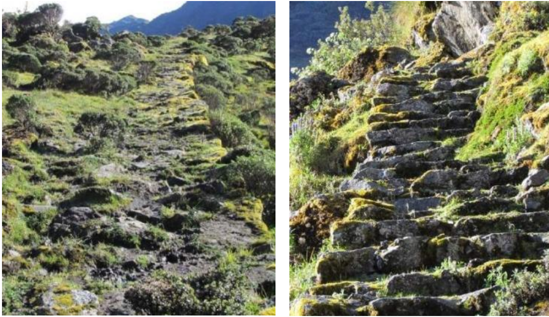
Fotos 70 y 71; A la izquierda se observa el camino con calzada empedrada y muro de sostenimiento, a la derecha escalinata con pasos y contra pasos en terreno inclinado, estos segmentos se hallan restaurados por el proyecto Qhapaq Ñan en el año 2004.
