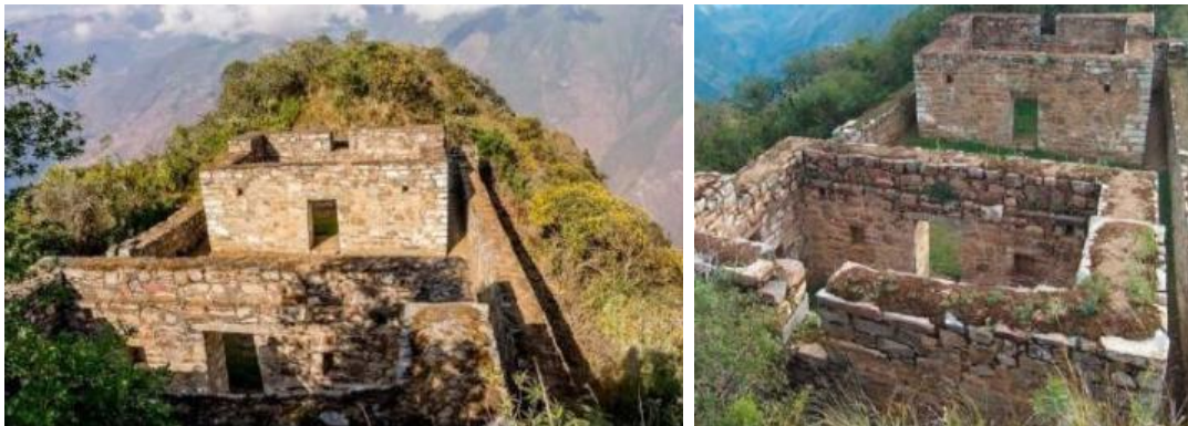
Fotos 96 y 97: Se observan los dos recintos de plantas rectangulares amurallados por un muro perimetral, sector Sacerdotes.
