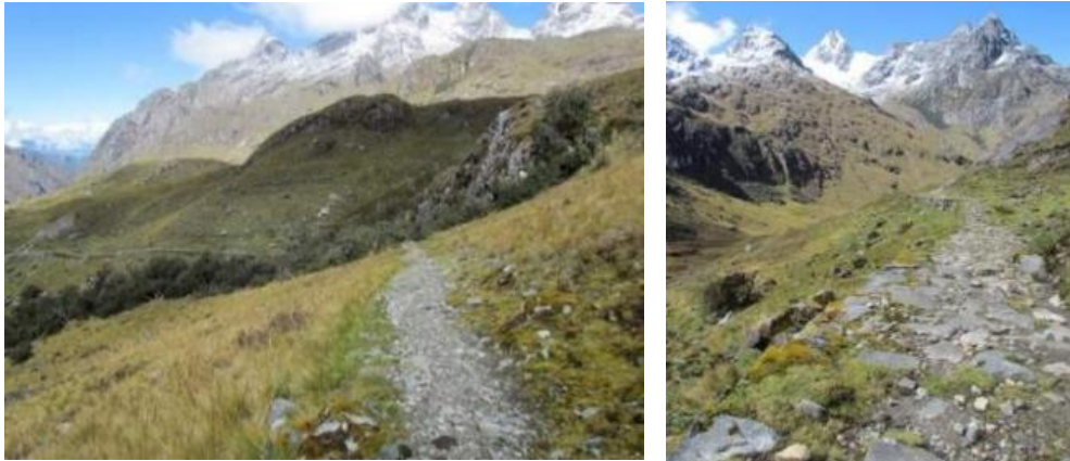
Fotos 75 y 76: Se observa parte de la calzada del camino en uso actual en el sector de Qewiñatranka, tiene plataforma empedrada con muro de sostenimiento de terraplen, fue restaurado en 2004 por el proyecto Qhapaq Ñan.
