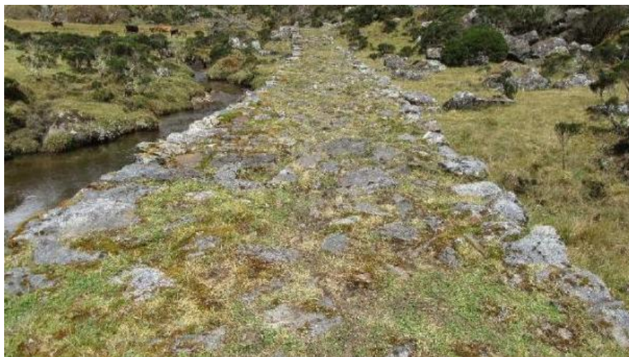
Foto 12: Camino en calzada empedrada emplazada en las partes llanas o espacios inundados, foto sector Samarinapata.
