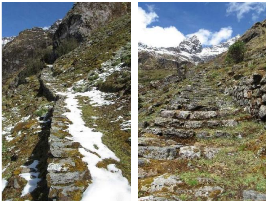
Fotos 22 y 23: Evidencias del camino en tipología de plataforma empedrada con muro de sostenimiento de terraplén y escalinatas con muro de sostenimiento de talud y terraplén en el abra de Choquetakapu.
