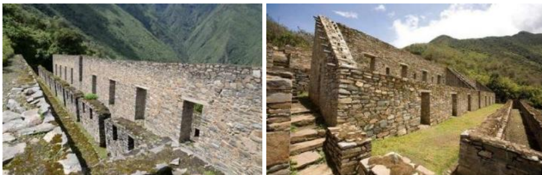
Fotos 88 y 89: Muros de las qollqas, se observan los procesos de restauración y mantenimiento de las estructuras del sector.
