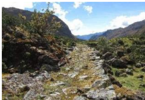
Fotos 72 y 73: Tipologías del camino en calzada elevada en desnivel y calzada empedrada en las partes llanas o espacios inundados, foto de sección Inka Mach'ay – Samarinapata.
