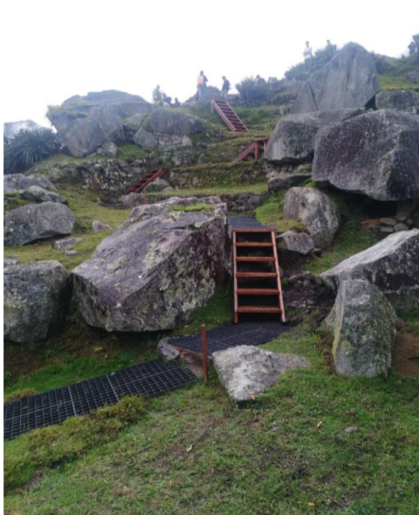
Figura 14: Uno de los nuevos senderos habilitados con escalinatas de madera y geoblocks en el sector I, conjunto 13 (Caos Granítico) que contribuye con la conservación de la llaqta y beneficia la visita con un flujo turístico más adecuado.
