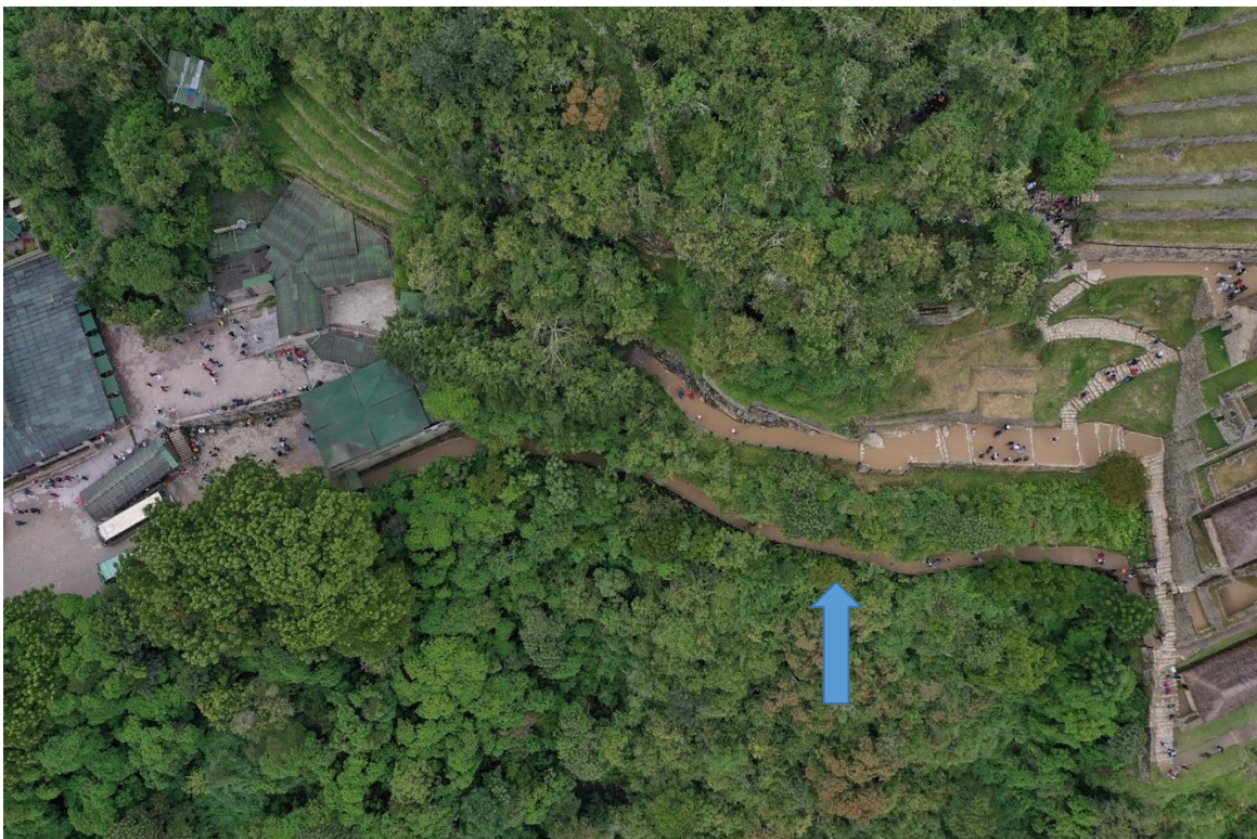
Figura 8: Rampa de salida de la llaqta de Machupicchu (marcada por la flecha azul) que se mimetiza con el entorno natural y ha permitido el ordenamiento y fluidez del flujo turístico.
