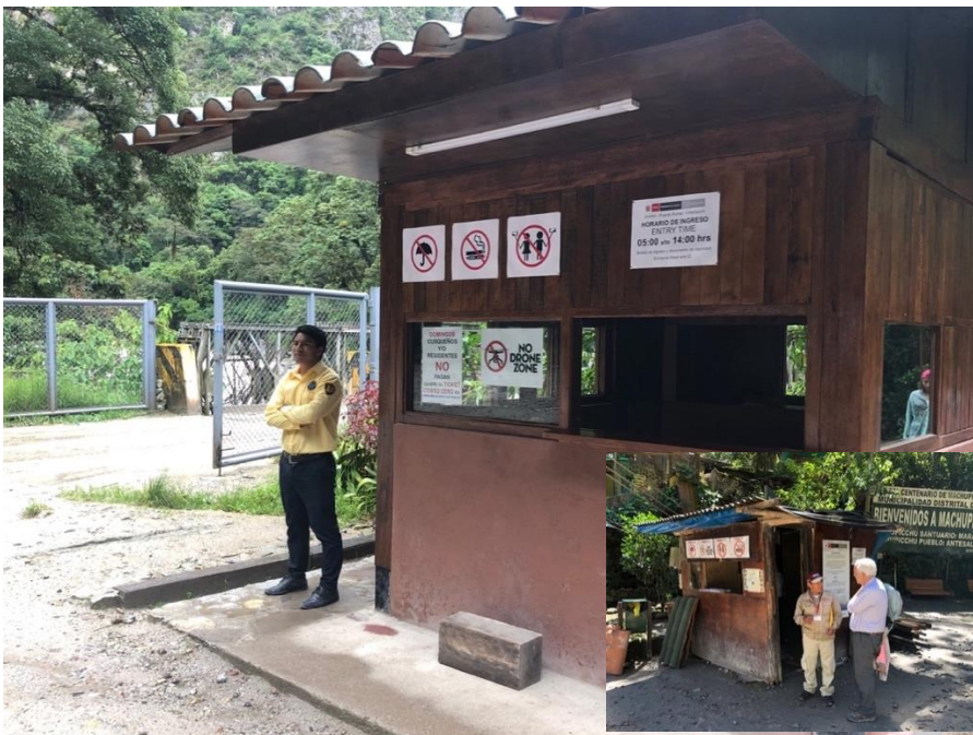
Figura 25: Nueva caseta de control y reja en Puente Ruinas.
